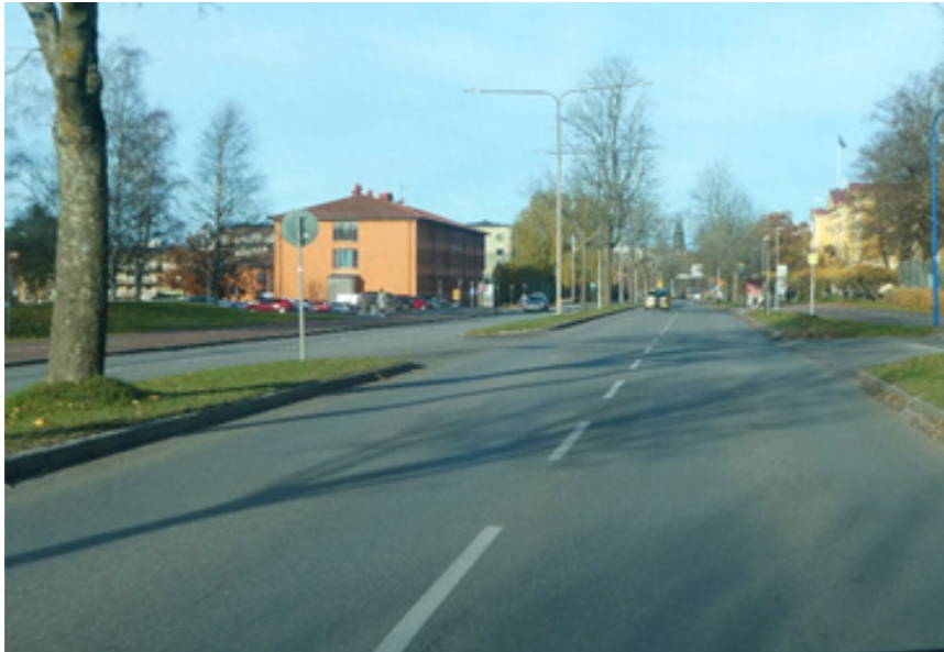
Figur 25. Den raka Dag Hammarskjölds väg med kasernbyggnader till höger samt domkyrkan och slottet i fonden. Vy från söder.
