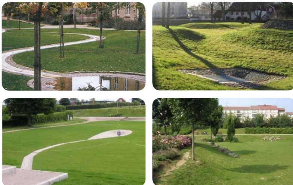
Figur 28. Exempel på översilningsytor, från Uppsala Vattens exempelsamling (2023).
