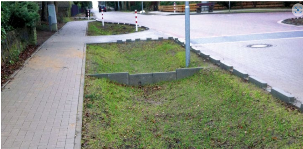
Figur 25. Svackdike med dämmen, foto taget från Stockholm Vatten och Avfall (2023).
