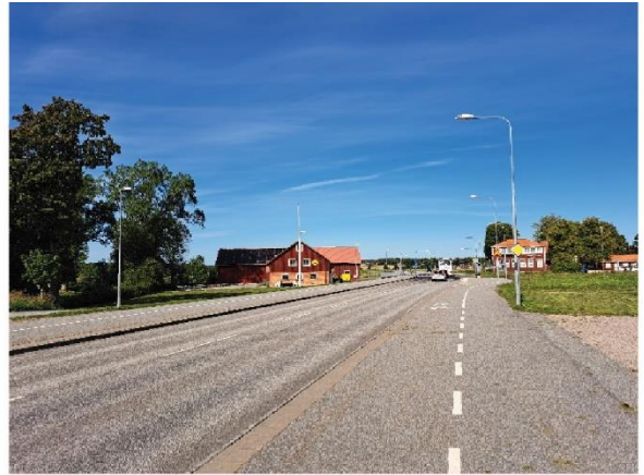
Gång- och cykelbana utmed Vattholmavägen
