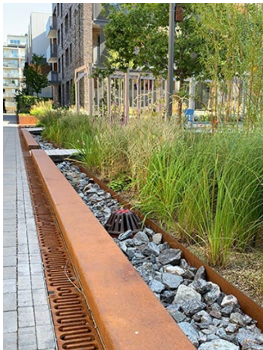
Bild 24: En upphöjd regnbädd som renar och fördröjer dagvatten i stadsmiljö (foto: Bjerking).
