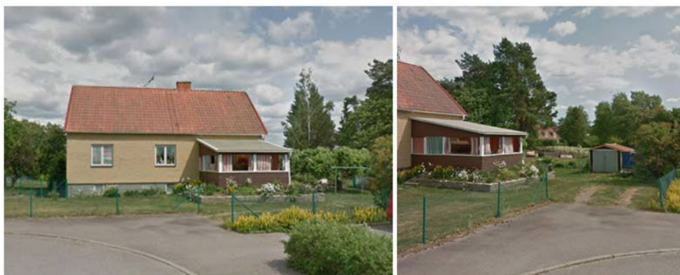
Figur 5 Byggnader inom fastigheten. Till vänster i bilden så syns huvudbyggnaden och i den högra så skymtas garagebyggnaden.
