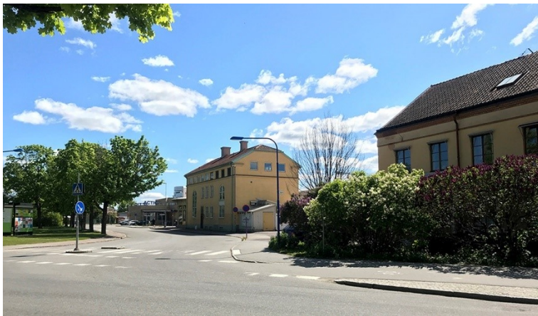
Nylunds pianofabrik och Bryggeriet Holmen sett från Bergsbrunnagatan.
