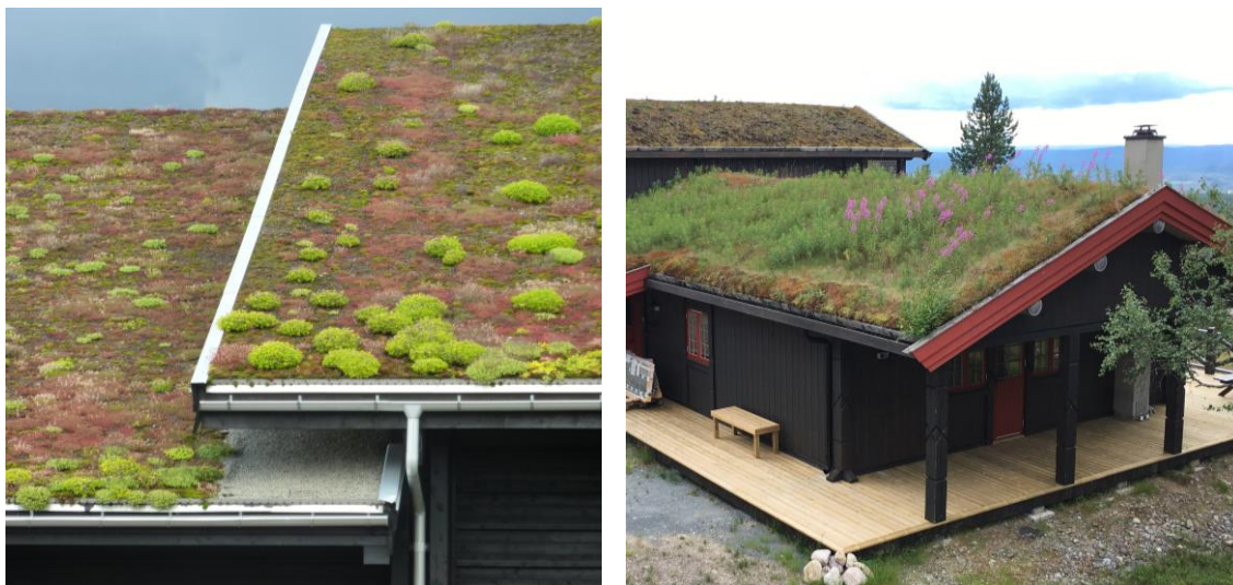
Figur 27. Två exempel på byggnader med gröna tak. Foto: WRS.
