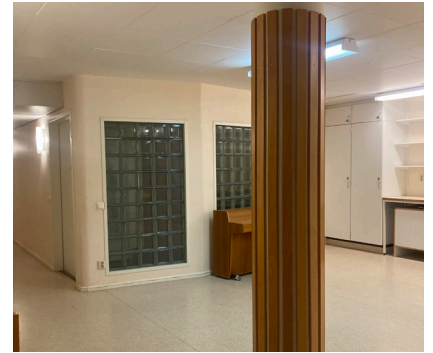
Pelare inklädd i panel. Betongglas öppnar upp mellan trappa och vistelserum på källarplanet.
