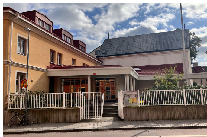
Kyrkobyggnaden med sin varierande utformning. Byggnaden nås från Slottsgränd. Nivåskillnader mellan gata och fastighet jämnas ut med stödmur och avgränsas med stålräcken.
