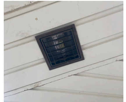
Undersida skärmtak med tidstypisk belysning och panelformad plåt.
