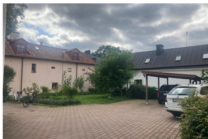
Vy mot innergården. Gården domineras av hårdgjorda ytor och ramas till största del in av bebyggelse. Betongplattorna är en del av den ursprungliga gestaltningen.
