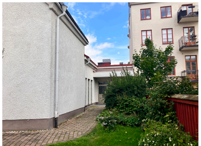
Kyrkosalens södra långsida har ett stramt uttryck. De sprit-putsade fasaden avslutas med en gesims. Sidoskeppet markeras med spröjsade glaspartier.
