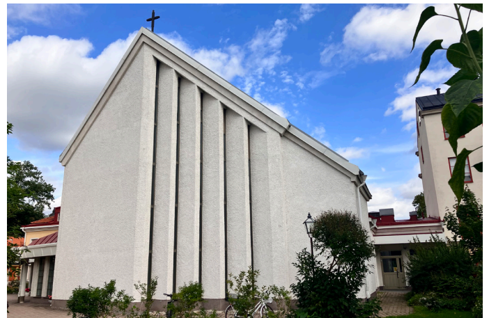
Kyrkosalens västra gavel har ett veckat fasadparti. I respektive vinkel finns ett långsmalt glasparti som sträcker sig vertikalt över fasaden. Byggnaden har ett karaktäristiskt tak.
