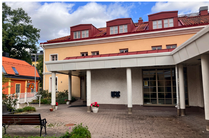
Volym D med innanförvarande entréhall. Lågdelen ansluter även till kyrkans norra långsida och bildar det ena sidoskeppet i kyrksalen.
