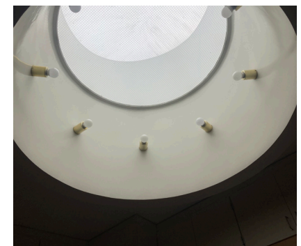
Runt takfönster med belysning.
