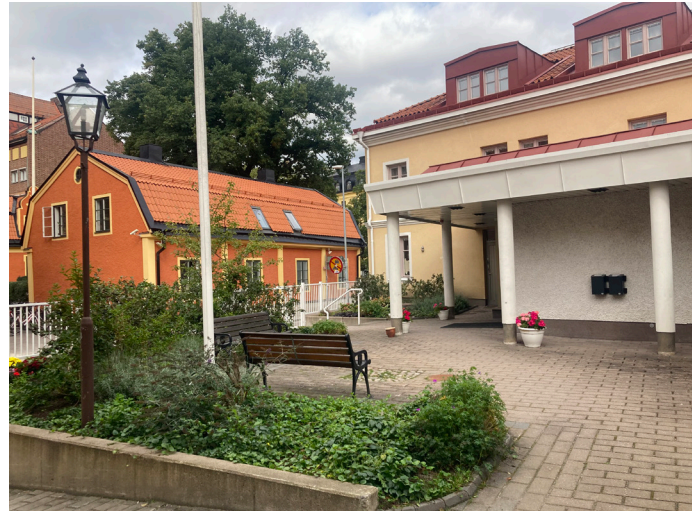
Ytor utmed byggnader och mot Slottsgränd är belagda med mönsterläggning av betongplattor. På bilden syns ursprungliga sittbänkar. Betongytan ramar in av buskage och planteringar.
