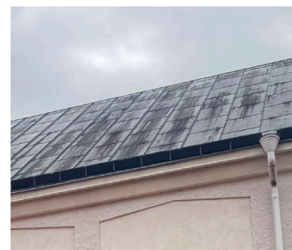
Skivtäckning av plåt med äldre dimensioner.
