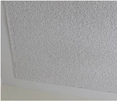
Spritputsade tak- och väggpartier.
