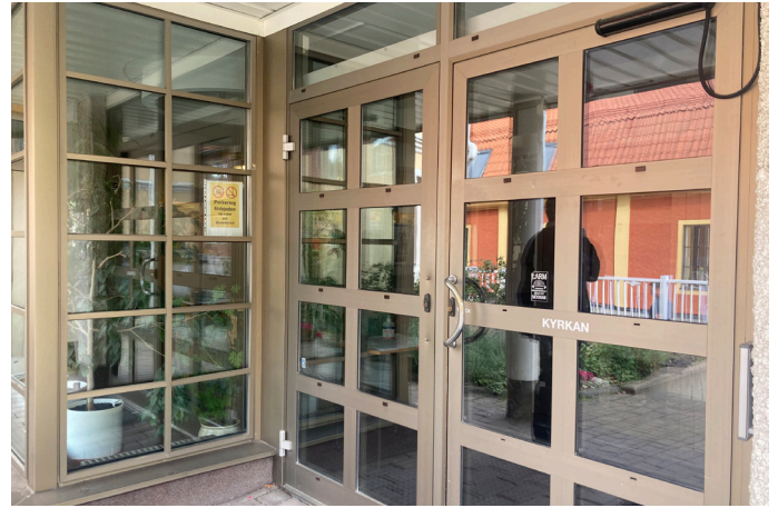
Huvudentré till kyrkobyggnad. Entrén har dubbla dörrblad med rektangulära glaspartier. Entrén möts av spröjsade glaspartier. Till bågar, karmar och dörrar används guldfärgad aluminium som är karaktäristiskt för byggnaden och tillkomsttiden.
