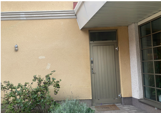
Entré till volym C. Dörren är i aluminium med ett överljus. Ovan dörren syns skärmtak och en profilerad gördelgesims.
