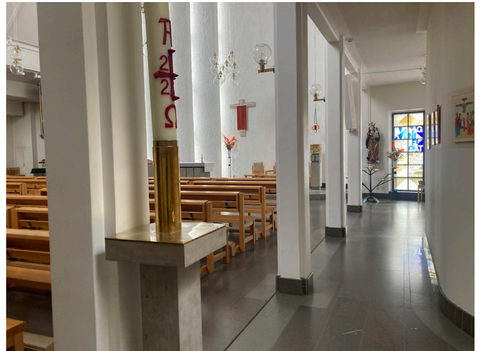
Kyrksalen har referenser till en basilika med sidoskepp utmed mittskeppet. Sidoskeppet får ljus från större glaspartier.
