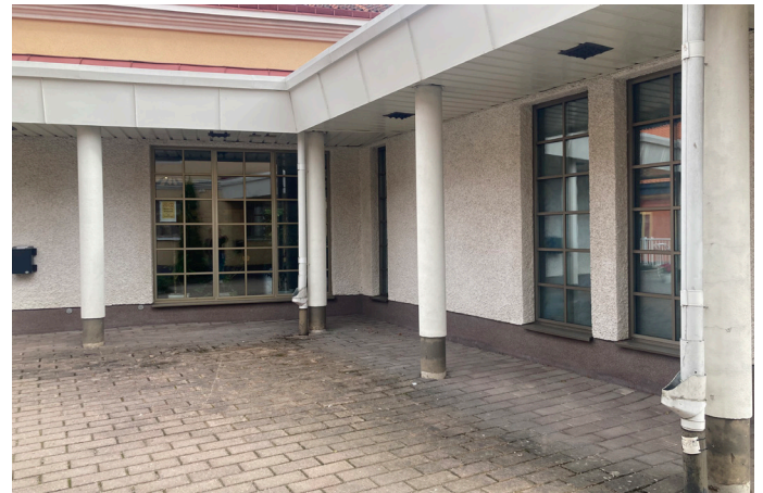
Till lågdelen ansluter ett skärmtak som löper utmed fasaden. Skärmtaket bärs av pelare. Undertill är skärmtaket klätt med brädformad plåt. Lågdelen har höga spröjsade glaspartier.
