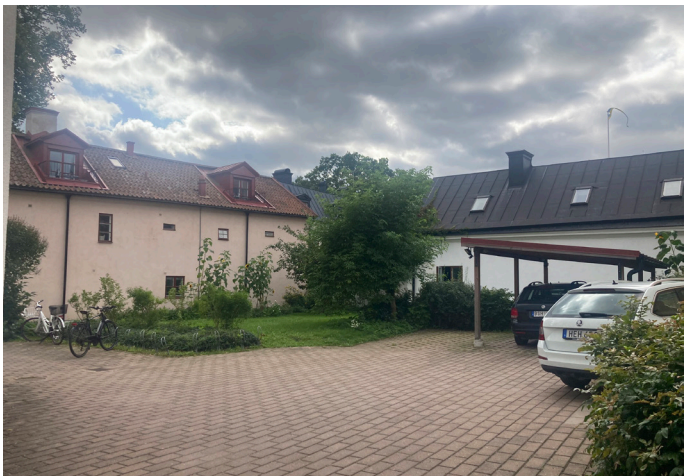
Vy mot innergården. Gården domineras av hårdgjorda ytor, och omges till största del av bebyggelse. Betongplattorna är en del av den ursprungliga gestaltningen.
