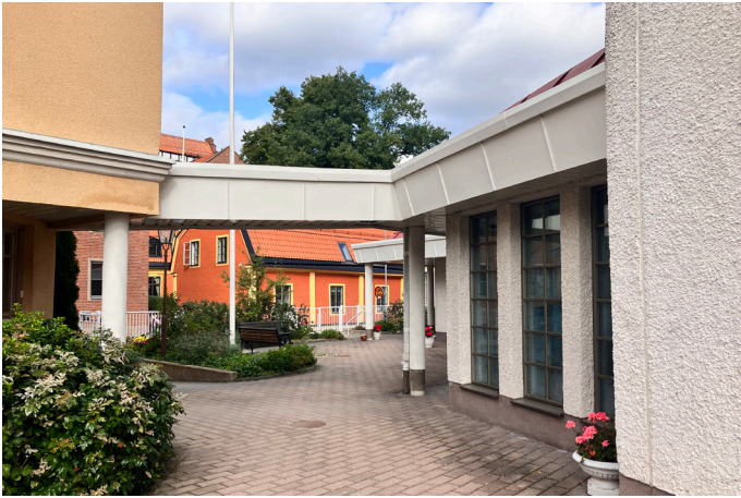
Lågdelen och Systrarnas hus sammanbinds med ett robust skärmtak. Skärmtaket stöds av vita pelare. I fonden skymtas bebyggelsen inom kvarteret belägen norr om fastigheten.
