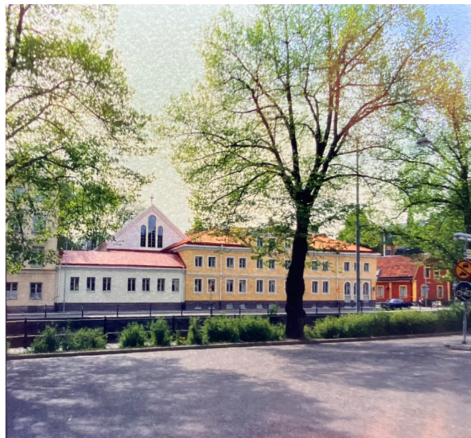
Diabild som visar anläggningen mot årummet. Hus B, uppfört i ett plan, underordnar sig Olympen både i skala och uttryck. Kyrkosalen skymmas bakom framförvarande volymer med rundbågiga höga fönster i gavelspetsen. Byggnadernas varierande karaktär bygger vidare på bebyggelsemiljöns varierande karaktär tillkommen vid olika tidpunkter. Källa: S:t Lars församling
