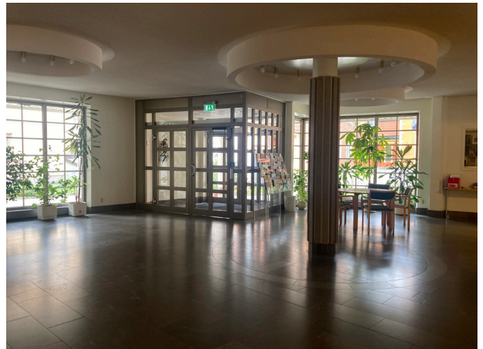
Rymlig entréhall med mönsterlagt kalkstengolv. Vindfång är i glas och guldfärgad aluminium. Pelare inklädd med betongsskivor. I taket syns runda formationer för belysning.
