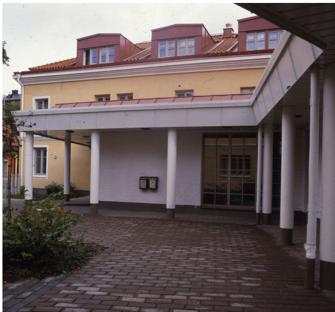
Bild tagen från innergården mot lågdelen med entréhallen. Lågdelen skapar en välavvägd övergång mellan gårdsrum och byggnad. Olika volymverkan och exteriöra material och kulör ger ett varierande uttryck. Skärmtaket bärs av pelare utmed fasaden. Foto: Göran Lindahl, 1986. Källa: Alvin
