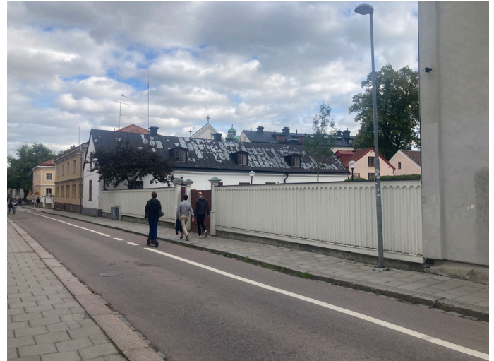
En flygelbyggnad och en rosafärgad volym avgränsar Katolska kyrkan från Grillska gården. Släpp och gårdsrum mellan byggnadsvolymer bidrar till en uppbruten och luftig karaktär i stadsrummet med möjlighet till utblickar.
