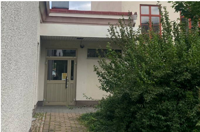
Volym B är flankerad i kyrkobyggnaden och den intillvarande Olympen. På den östra fasaden finns en entré med entrédörr i aluminium med glasparti, sido- och överljus.
