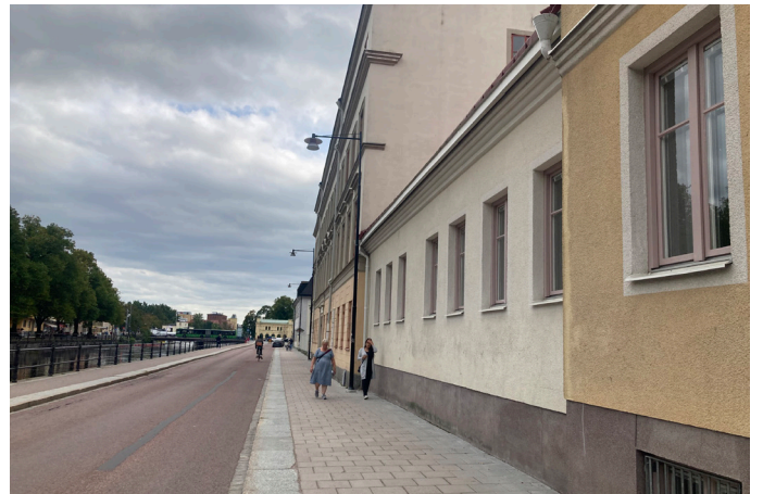
Volym B är flankerad av Olympen. Den har ett återhållsamt uttryck och underordnar sig Olympen. Fasaderna är putsade och avslutas med en gesims. Korspostfönster indragna i fasadliv.
