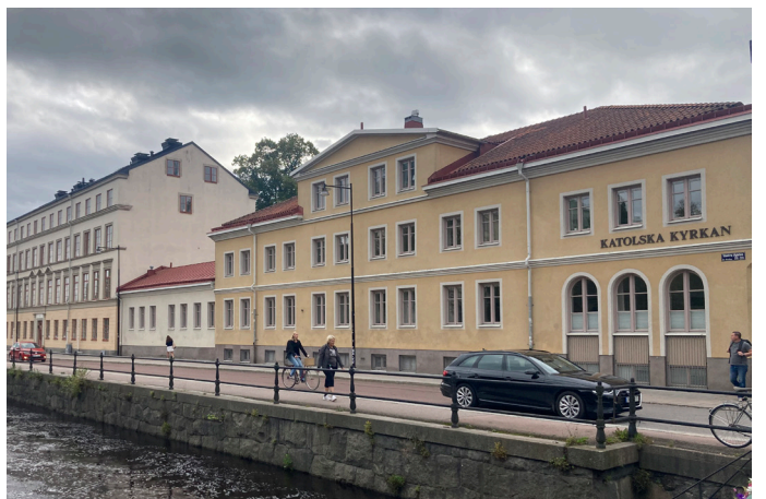
Volym C med långsidan mot årummet. Gesimser, gaveluppbyggnad med fronton, valmat tak och rundbågiga fönster bidrar till byggnadens ålderdomliga prägel.
