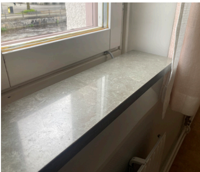
Fönsterbräda av sten.
