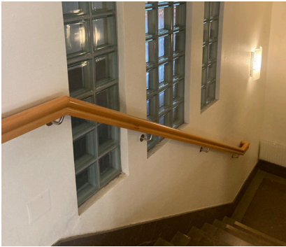
Primär trappa med steg och vilplan i kalksten. Robust handledare i massivt trä. Ljusinsläpp via betongglas.
