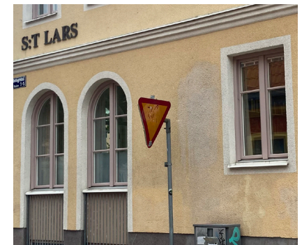
Rundbågiga fönster och korspostfönster.
