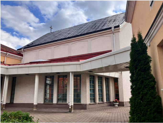
Kyrkosalens norra långsida med blindingar. Sidoskeppet mynnar ut i lågdelen. Sidoskeppet har spröjsade glaspartier. Kyrkosalen har ett plåtklätt tak med äldre dimensioner på plåten.
