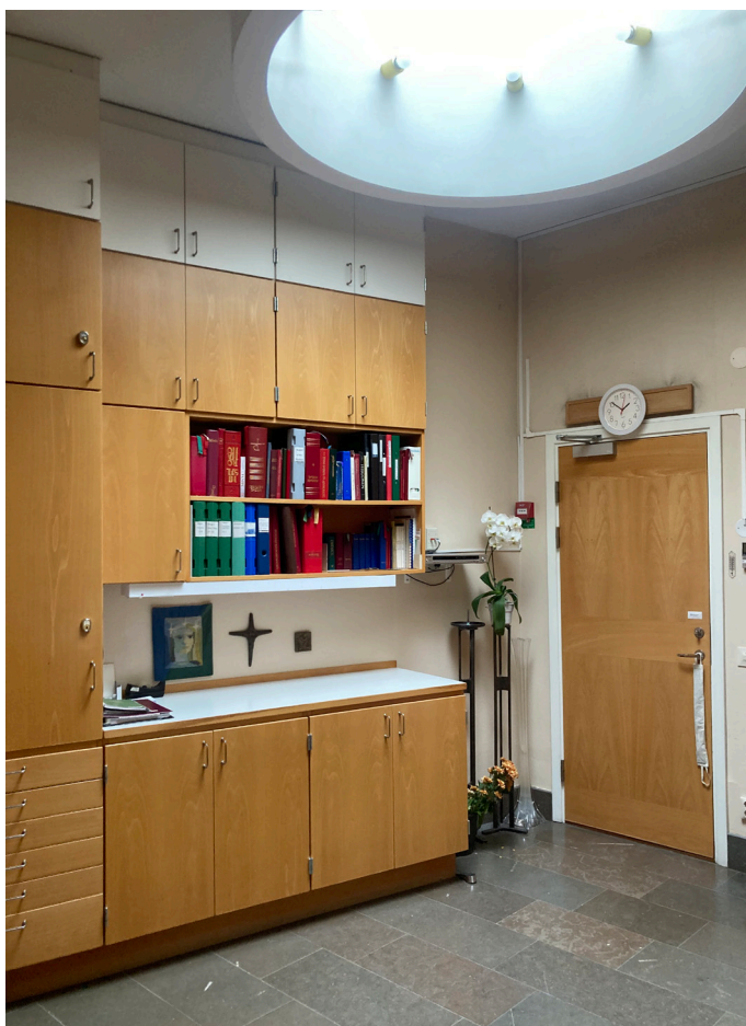
Sakristian med en sammanhållen utformning. Skåpluckor och dörr i ädelträ. Golvet är beklätt med kalksten. Rummet har ljusinsläpp genom ett cirkelformat takljusfönster.
