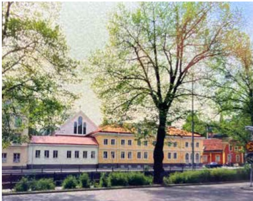
Figur 12 Foto som visar anläggningen mot årrummet. Kyrkosalen skymtas bakom framförvarande volymer med rundbågiga höga fönster i gavlespetsen. Byggnadernas varierande karaktär bygger vidare på bebyggelsemiljöns varierande karaktär tillkommen vid olika tidsskeden. Källa: S:t Lars församling.
