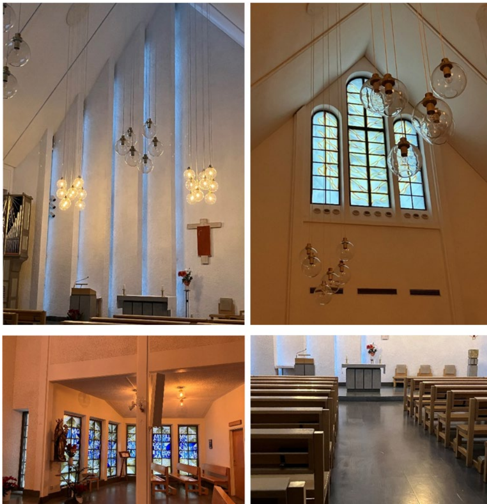
Figur 27 inrednings- och fasaddetaljer i kyrksalen: väggen i koret med snedställt ljusinsläpp, rundbågiga spröjsade fönster, långsmala vertikala glaspartier, den öppna karaktären med fristående pelare, golvet.
