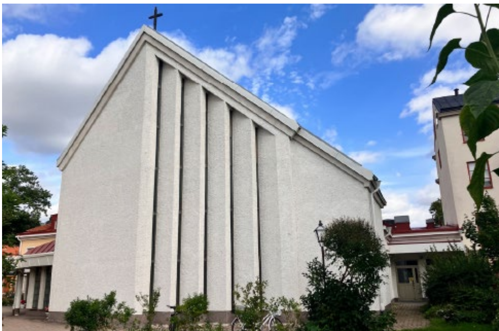
Figur 28 Kyrksalens västra gavel har ett veckat fasadparti. I respektive vinkel finns ett långsmalt glasparti som sträcker sig vertikalt över fasaden. Byggnaden har ett karaktäristiskt tak. Källa: kulturmiljöanalys, White arkitekter.
