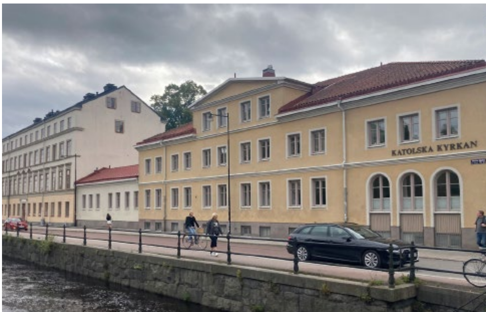
Figur 29 Kyrkobyggnad med långsidan mot årummet. Gesimser, gavelupp-byggnad med fronton, valmat tak och rundbågiga fönster bidrar till byggnadens ålderdomliga prägel. Källa: kulturmiljöanalys, White arkitekter.
