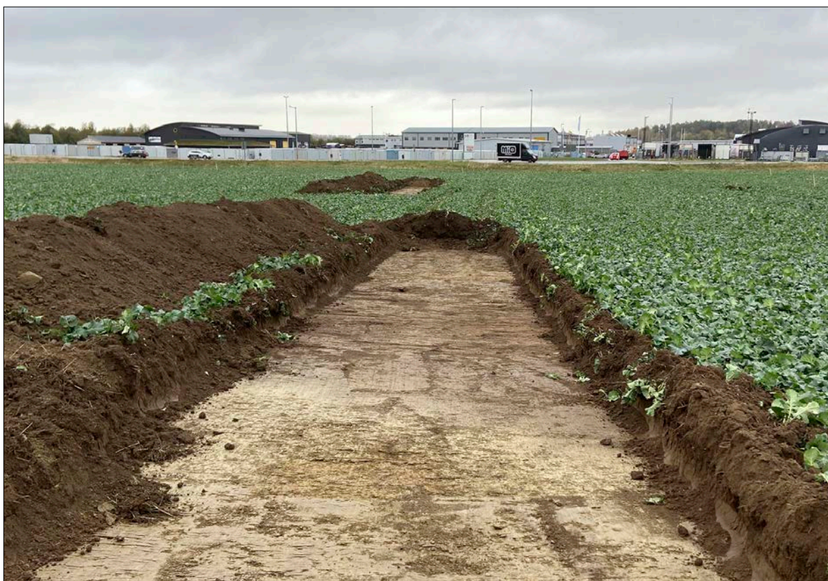
Figur 10. Lager 103 i schakt 1007. Foto från sydväst.
