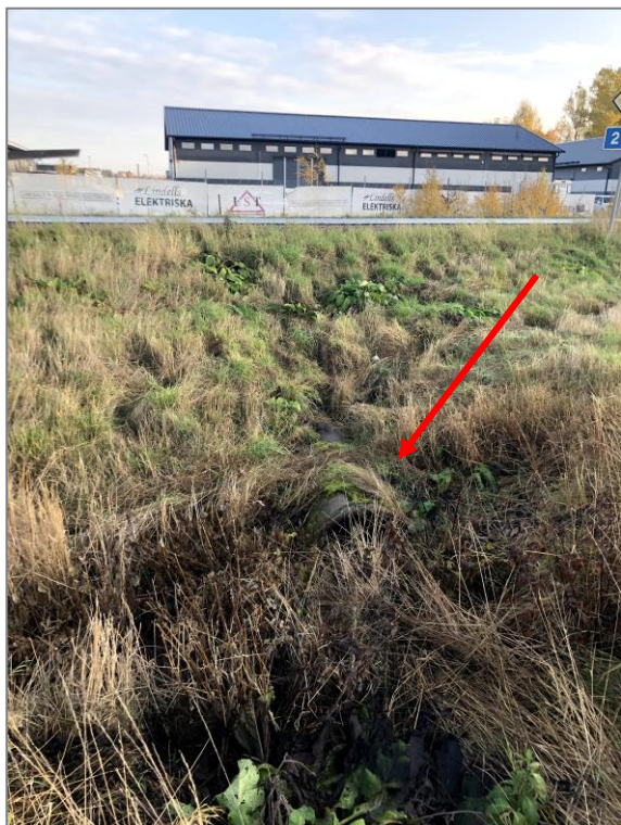
Foto 5. Kulvert i nordväst som leder dagvatten under Börjegatan. Kulverten markerad med röd pil.
