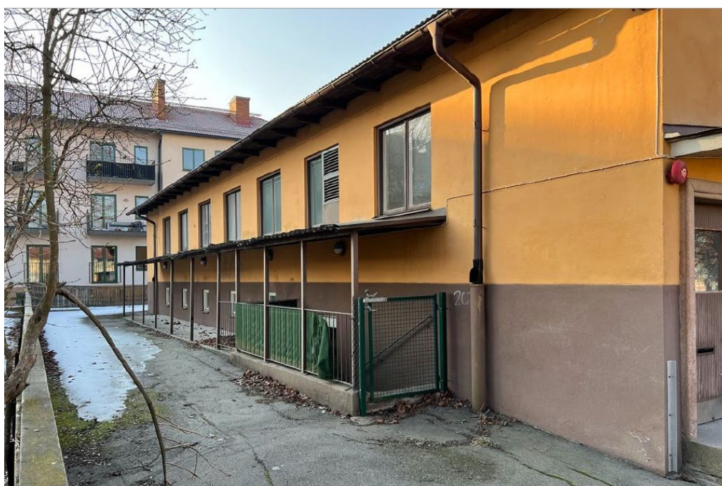
Figur 12 visar skärmtak på den bakomliggande fasaden och trappa som leder till källarvåningen. Del av skärmtaket trappan och två fönster och en dörr behöver rivas för att möjliggöra en hiss. Källa: Hille hus o Historia AB.
