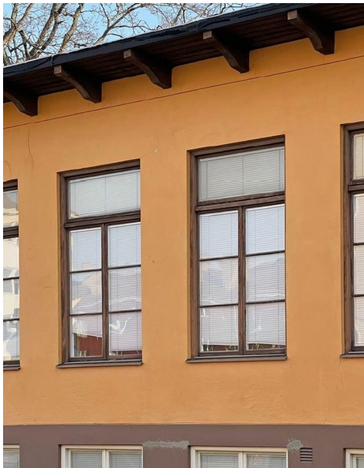
Figur 22 foton visar ursprungliga snickerierna såsom fönster och sparrarna vid takfoten samt en del av fasaden murad med lättbetong som putsats och målats i en ockragul kulör. De skyddas med planbestämmelsen k2 och q4. Källa: antikvarisk konsekvensbedömning, Hille hus o Historia AB.
