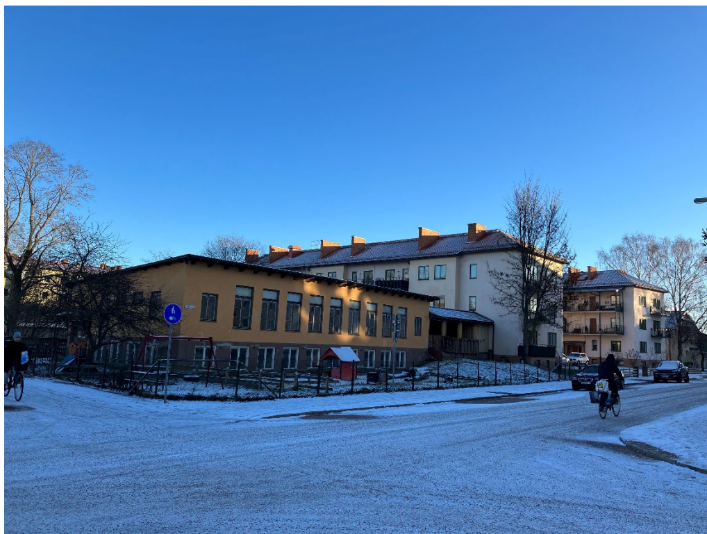
Figur 11 Fotografi visar barnstugans fasader mot Torkelsgatan och mot gc-vägen. Källa: Uppsala kommun.
