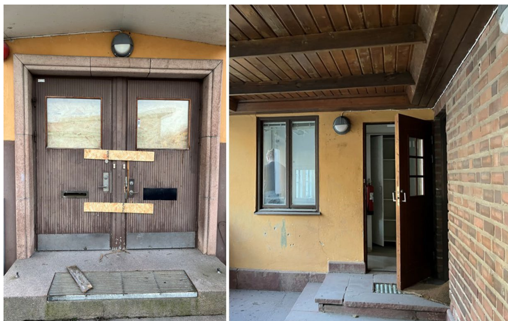
Figur 19 Foton visar entrédörrar med omfattningen av Roslagssten som skyddas med planbestämmelse q2 och fönster och dörrar som exempel på karakteristiska ursprungliga byggnadsdetaljer som skyddas med planbestämmelsen q4. Foton höger också visar loggians golvbeläggning av röd kalksten samt tegelvägg som ska bevaras. Det regleras med planbestämmelse q1. Källa: Hille hus o Historia AB.
