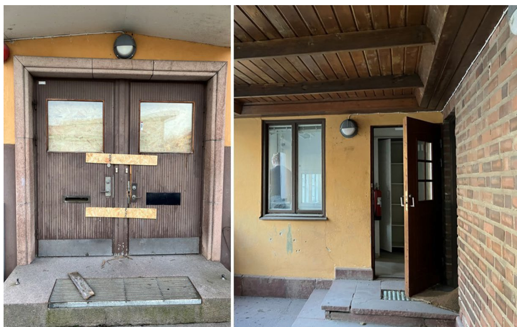
Figur 19 Fotona visar entrédörrar med omfattningen av Roslagssten som skyddas med planbestämmelse q2 och fönster och dörrar som exempel på karakteristiska ursprungliga byggnadsdetaljer som skyddas med planbestämmelsen q4. Foton höger också visar loggians golvbeläggning av röd kalksten samt tegelvägg som ska bevaras. Det regleras med planbestämmelse q1. Källa: Hille hus o Historia AB.
