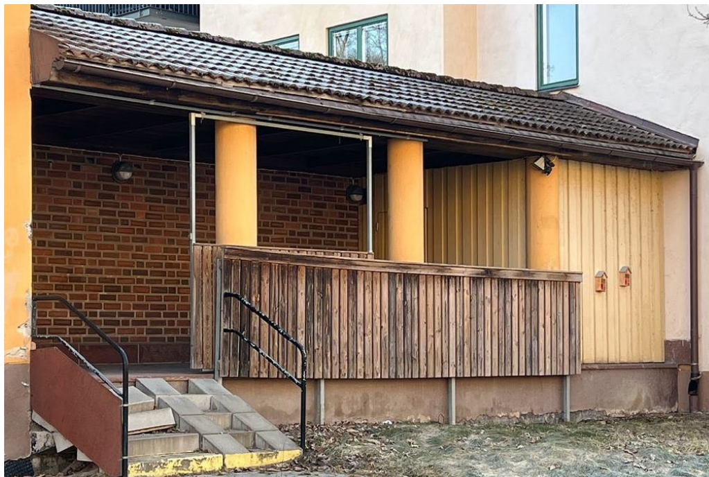
Figur 20 foton visar loggian vilkens socklar, trappa och golvbeläggning av röd kalksten samt tegelvägg och innertak ska bevaras. Det säkerställs med skyddsbestämmelse q1. Loggian får glasas in som regleras med planbestämmelse f1. Staket är inte ursprunglig och kan tas bort vid renoveringen för att uppnå utseende som liknar den ursprungliga. Det regleras dock inte med planbestämmelse. Källa: antikvarisk konsekvensbedömning, Hille hus o Historia AB.
