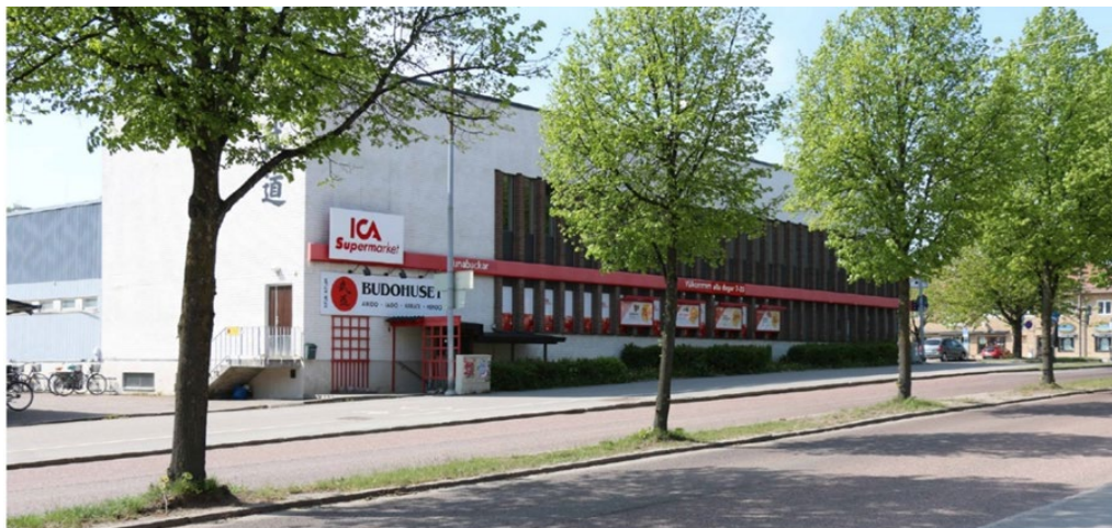
Bild 13 Befintlig byggnad med vissa kulturhistoriska värden.
