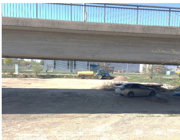
Parkering under Kungsängsbron, april 2019.
