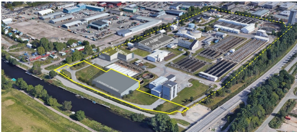
Hela reningsverket med föreslagna nya byggnader. Planområdet markerat med gul linje
