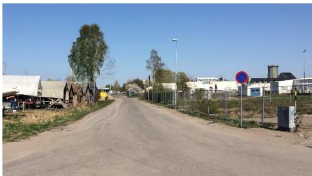
Den västra delen av Stallängsgatan. Området närmast i bild är planlagt som park men fungerar som gata och planläggs som det för att möjliggöra en ny utfart.
