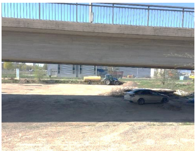
Parkering under Kungsängsbron, april 2019.
