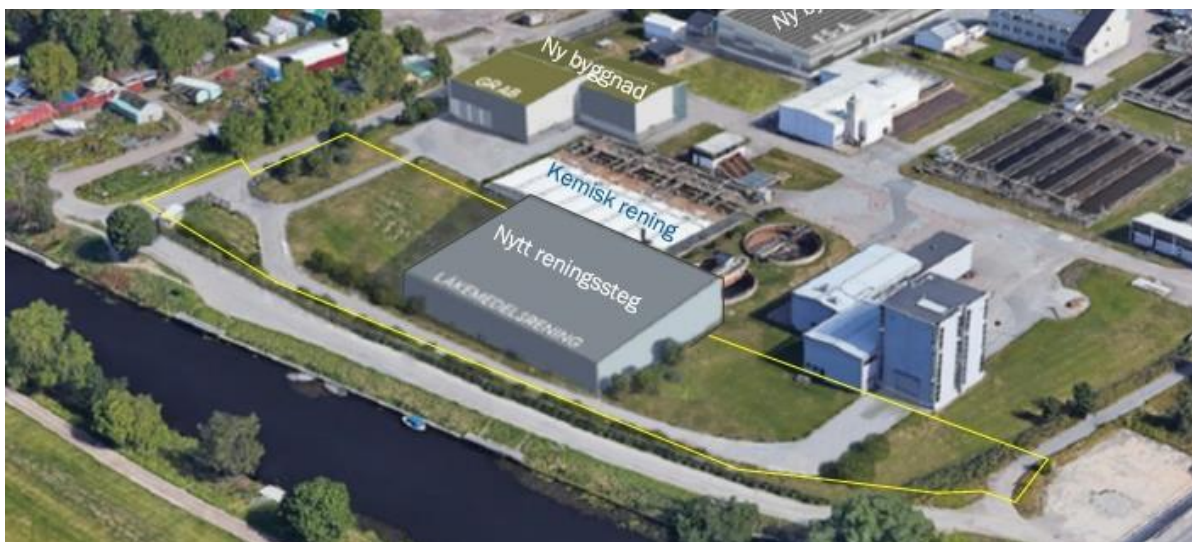
Volymstudie som visar största tänkbara överbyggnad till det nya reningssteget. Utanför planområdet, bakom det nya reningssteget och den befintliga kemiska reningen syns den planerade nya grovreningen "Ny byggnad GRAB B". (Denna byggnad ryms inom gällande detaljplan).
