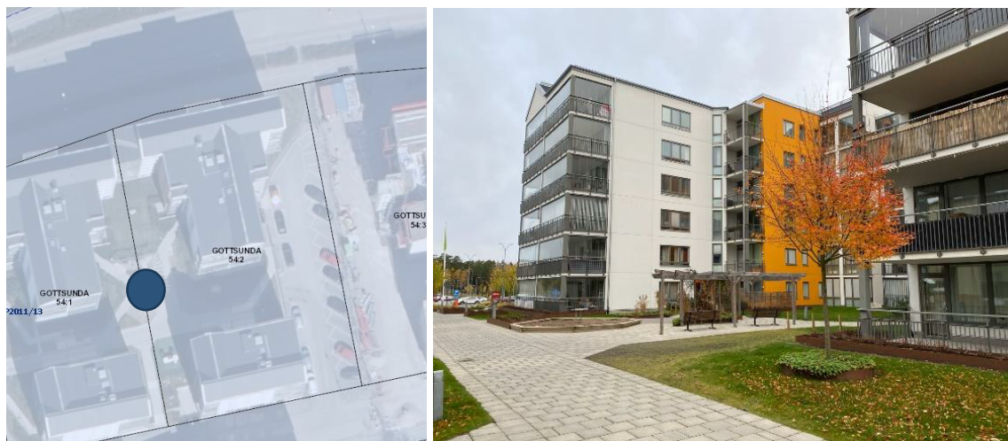
Figur 5 Vy över fastigheten
