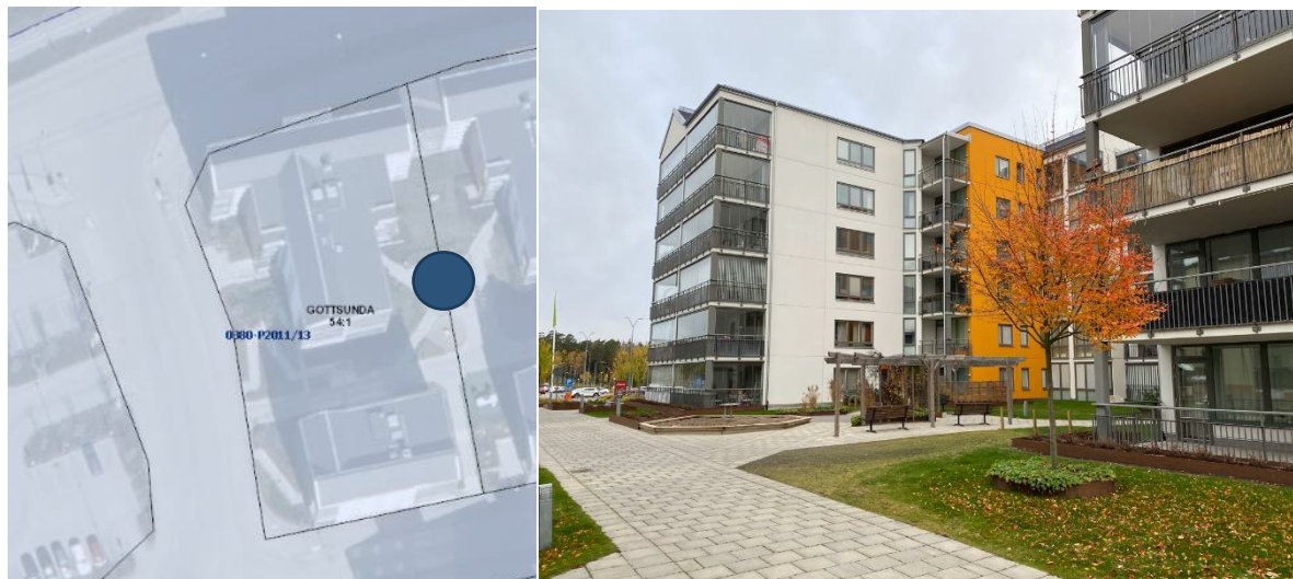
Figur 5 Vy över fastigheten
