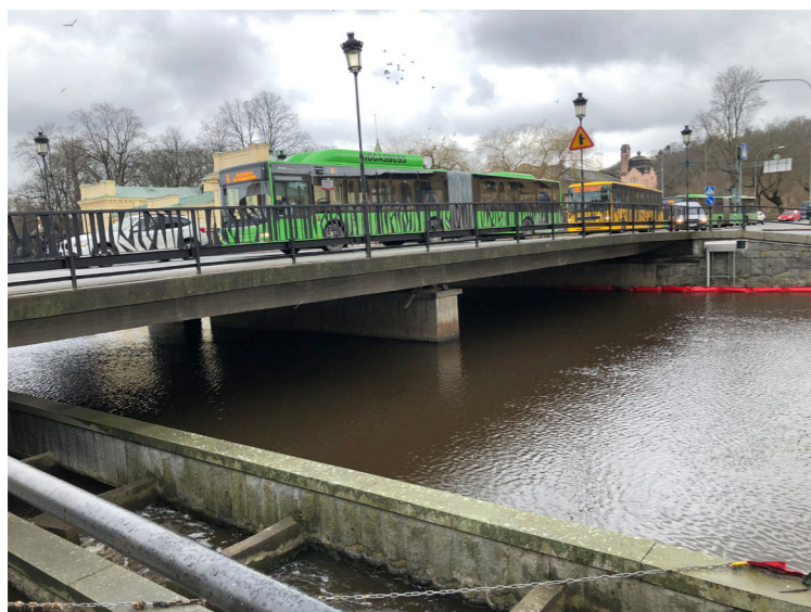
Vattenrummet under bron med asptrappa.
