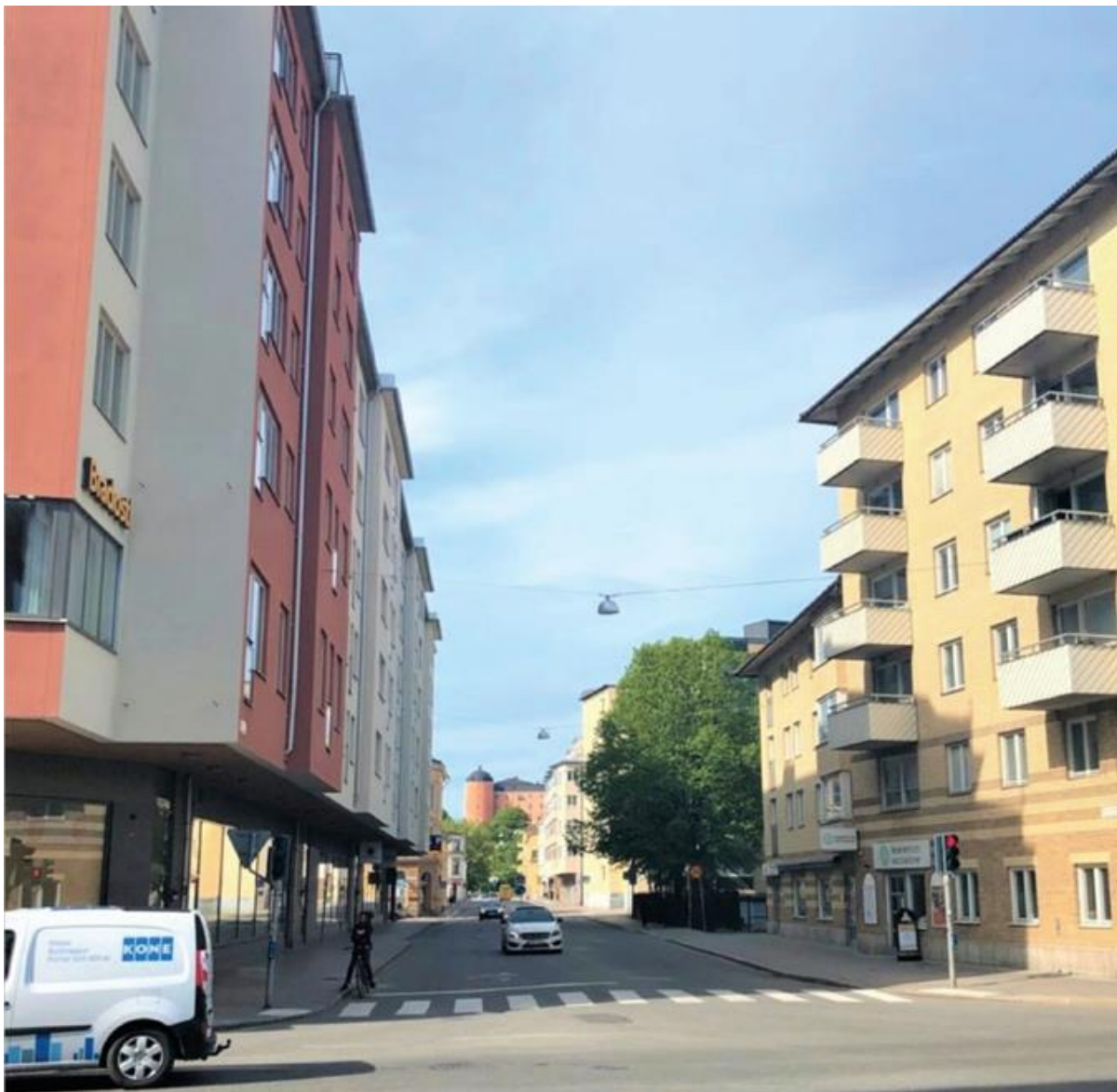
Figur 17. Bäverns gränd med slottets södra torn i fonden. Vy från öst. Foto: White arkitekter
