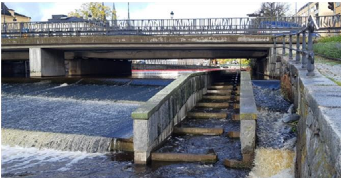
Figur 15. Asptrappan under Islandsfallet. Foto WSP Sverige AB
