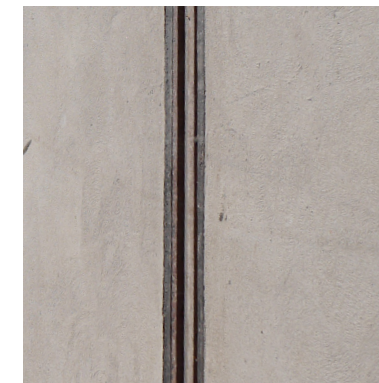
Figur 9. Betong i spår.
