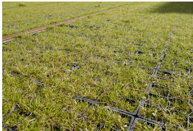
Figur 35. Armerat grässpår som kan trafikeras av räddningstjänst. Odense.
