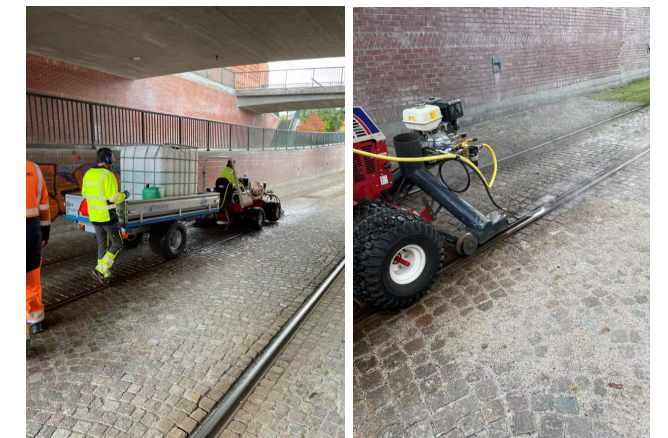
Figur 91. Renhållning av gaturäl i Lund med specialverktyg för högtrycksvätt monterat på skötselfordon. Bildkälla: Roy Haglund, driftsansvarig spårväg Lunds kommun
