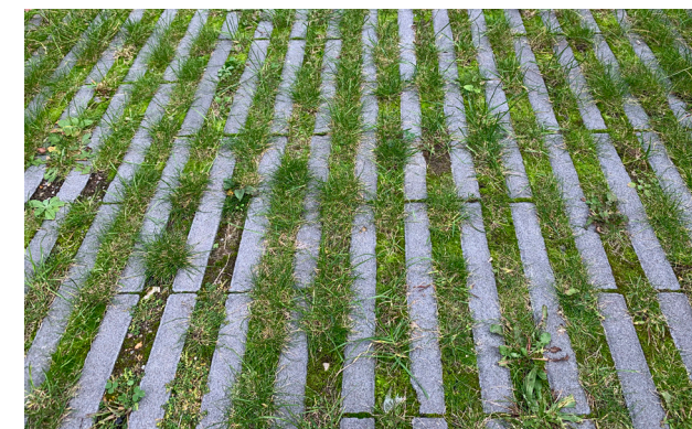
Figur 40. Exempel på beläggning med gräsarmering i betong.
