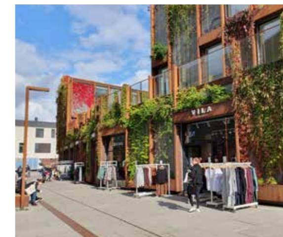
Exempel på växtklädd fasad.
