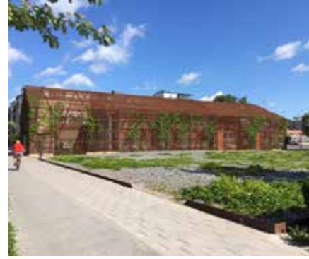
Exempel på inbyggd nätstation, Kungsängen Uppsala
