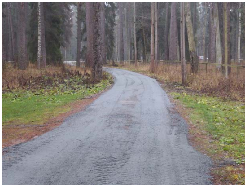
Figur 27 Foto 2 från besiktning innan åtgärder av väg.
