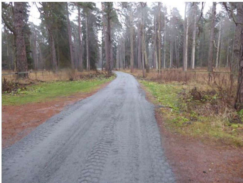
Figur 26 Foto 1 från besiktning innan åtgärder av väg.
