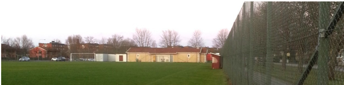
Bilden visar den byggnad som finns inom planområdet samt delar av den inhägnade 11-mannaplanen.
