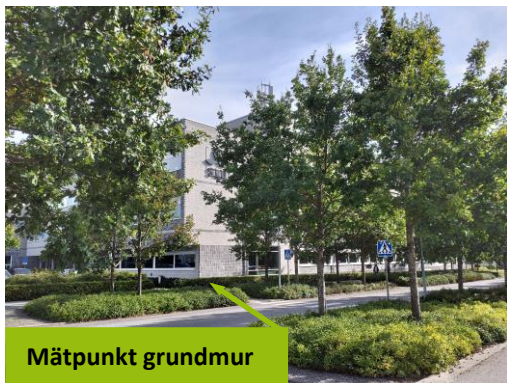
Bild 1. Vy över byggnad, mätpunkt 33.1.
