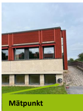
Bild 1. Vy över byggnad, mätpunkt 38.3.
