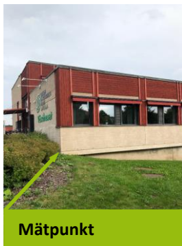
Bild 1. Vy över byggnad, mätpunkt 38.1.
