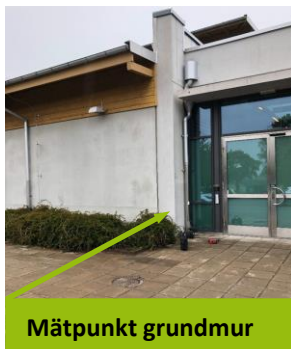
Bild 1. Vy över byggnad, mätpunkt 36.8.
