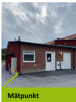
Bild 1. Vy över byggnad, mätpunkt 37.1.
