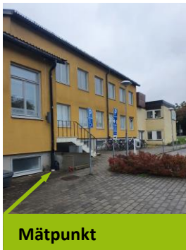
Bild 1. Vy över byggnad, mätpunkt 44.4.
