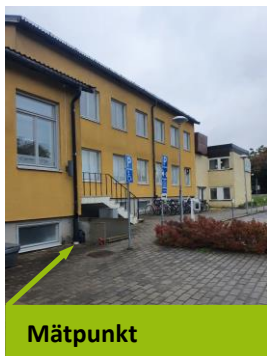
Bild 1. Vy över byggnad, mätpunkt 44.4.
