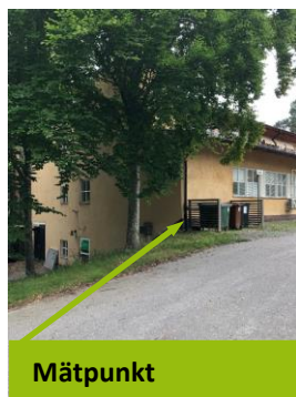
Bild 1. Vy över byggnad, mätpunkt 39.
