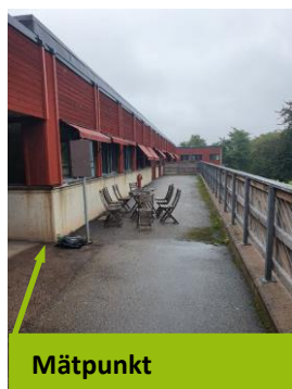
Bild 1. Vy över byggnad, mätpunkt 38.4.
