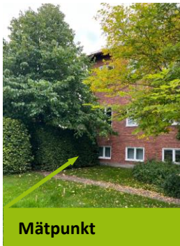
Bild 1. Vy över byggnad, mätpunkt 37.3.
