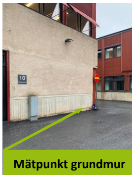
Bild 1. Vy över byggnad, mätpunkt 38.6.
