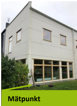
Bild 1. Vy över byggnad, mätpunkt 46.2.
