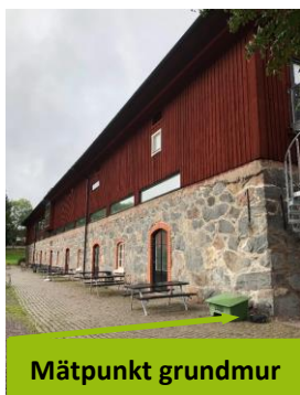
Bild 1. Vy över byggnad, mätpunkt 41.3.
