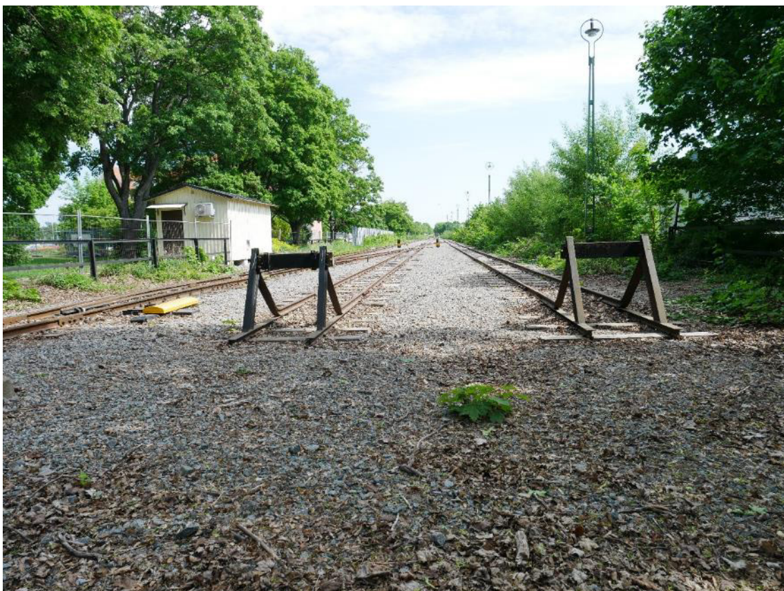
Figur 2.2.1-2. Driftbangårdens spår och teknikhus.
