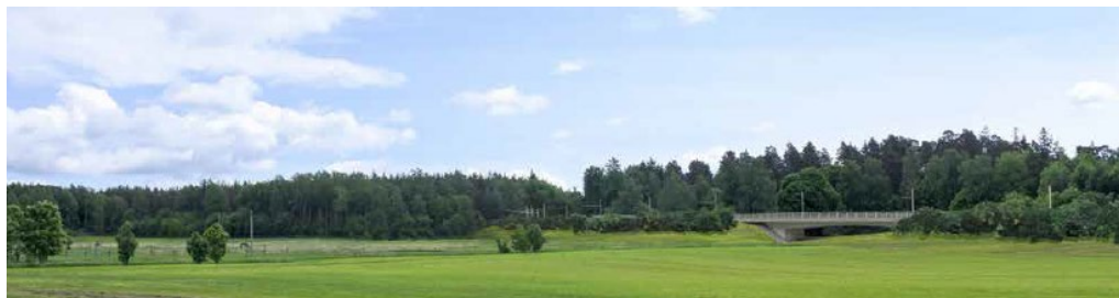
Figur 53: Fotomontage som visar korsningen med Hemslöjdsvägen. Hemslöjdsvägen sänks och går under spårvägen. På bilden syns också den tillkommande vegetationen som omger bron och bankarna. Bild: Bjerking och Rundquist arkitekter.
