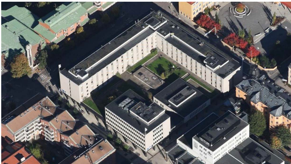
Flygbild över befintlig bebyggelse
