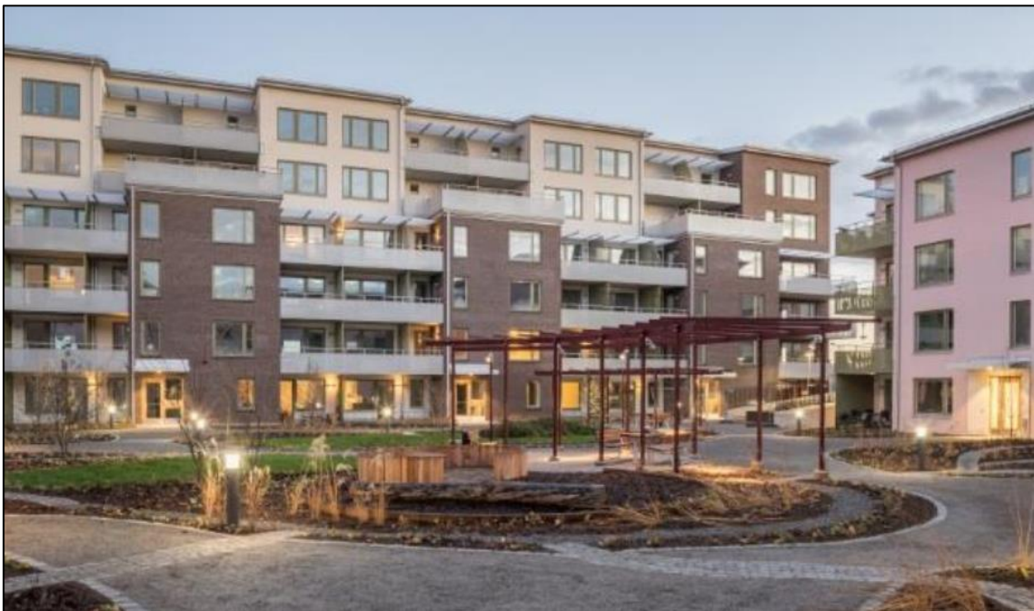
Figur 6-5. Avledning av takvatten till planteringar via rännदार anlagda i gatsten. Exempelillustration från Linnéhuset i Uppsala (Källa: Uppsalahem).
