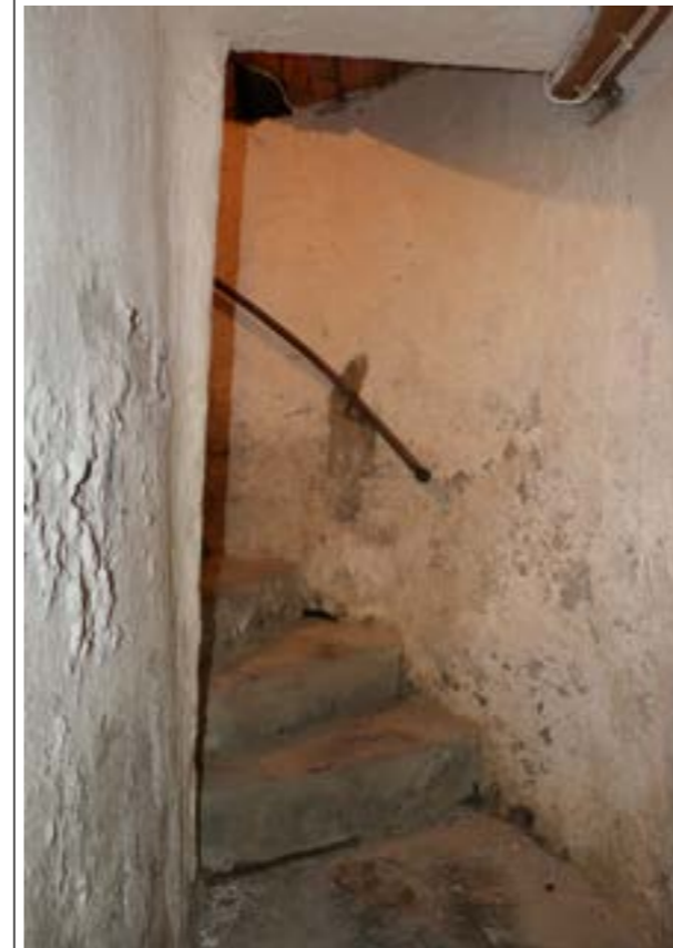
Gjuten trappa till källare.
