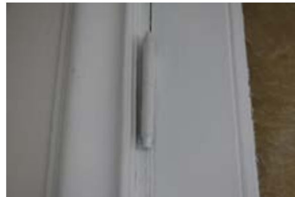
Ursprungligt gångjärnsbeslag och foder.
