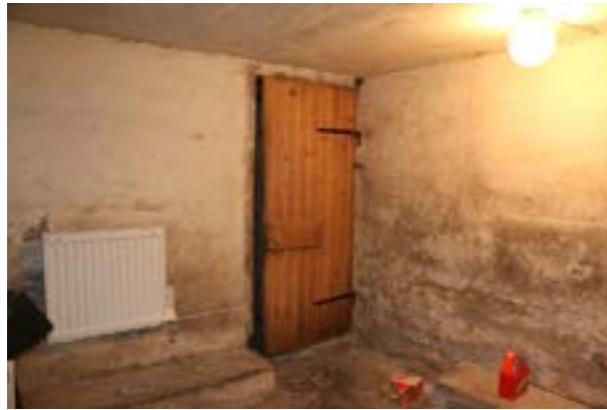
Källare med bräddörr.
