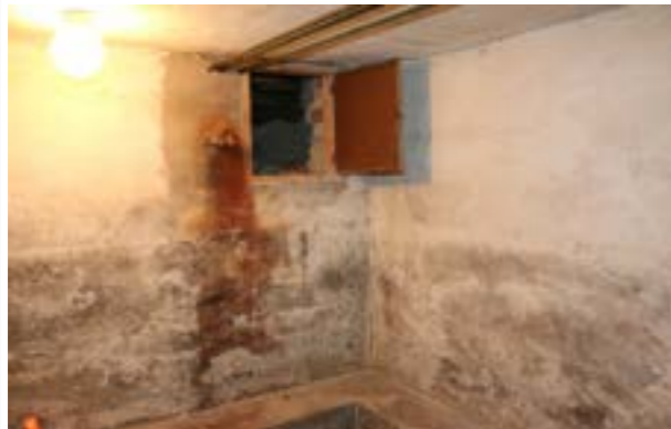
Gjutna väggar i källare.
