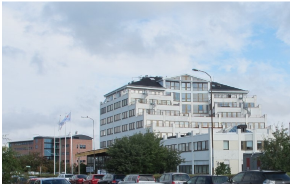
Foto från Vallongatan med kontorshuset Skeppet i fonden.
