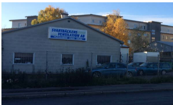
Den befintliga byggnaden på fastigheten Librobäck 12:8 sett från Fyrisvallsgatan.
