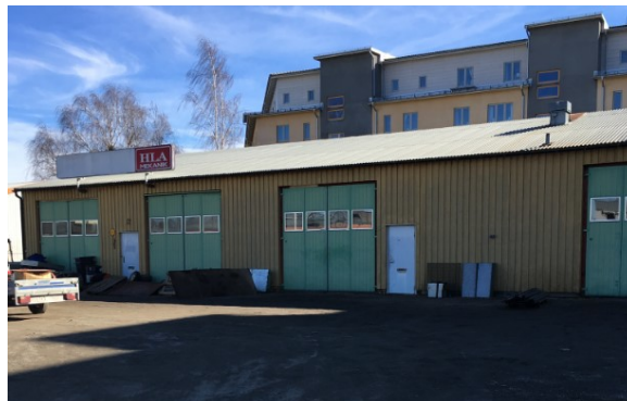
Den befintliga byggnaden på fastigheten Librobäck 12:9 sett från Fyrisvallsgatan.
