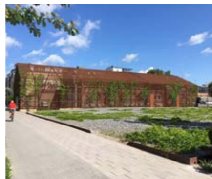
Exempel på inbyggd nätstation, Kungsängen Uppsala
