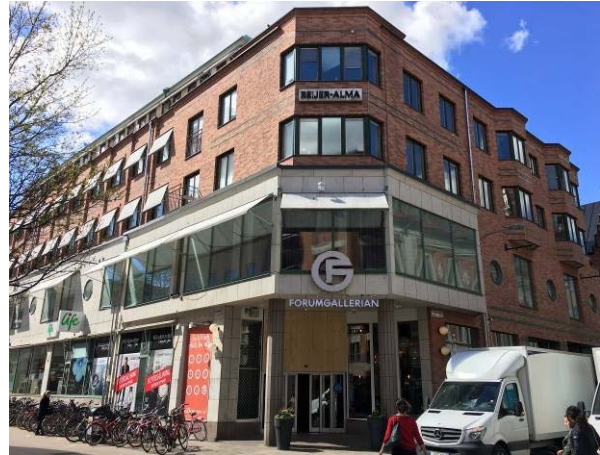
Forumgallerians 1990-talsdel sedd från Dragarbrunnsgatan.
