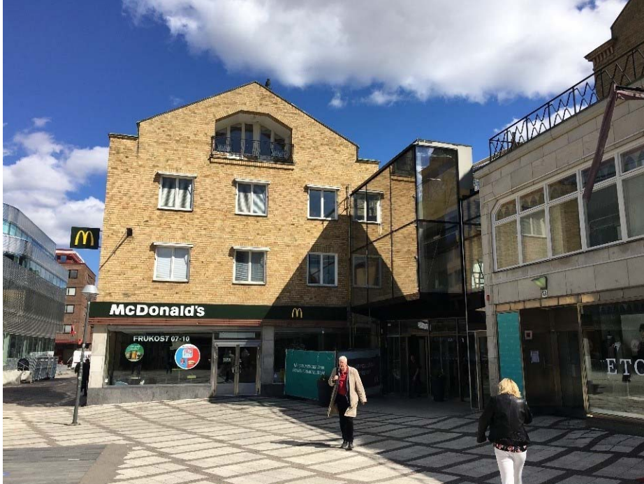
Foto på Forumtorget och entrén till Forumgallerian sett från Kungsängsgatan.
