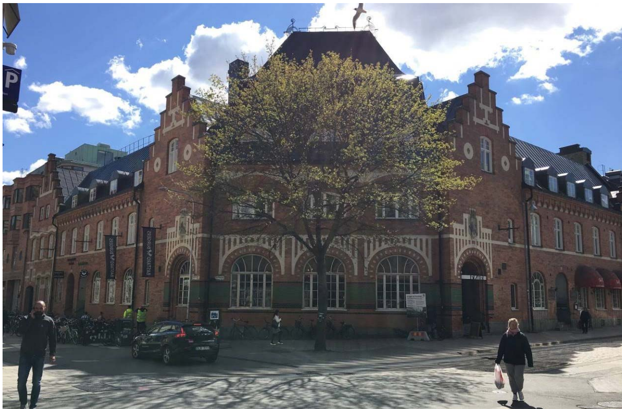
Spritpalatset sett från Dragarbrunnsgatan.
