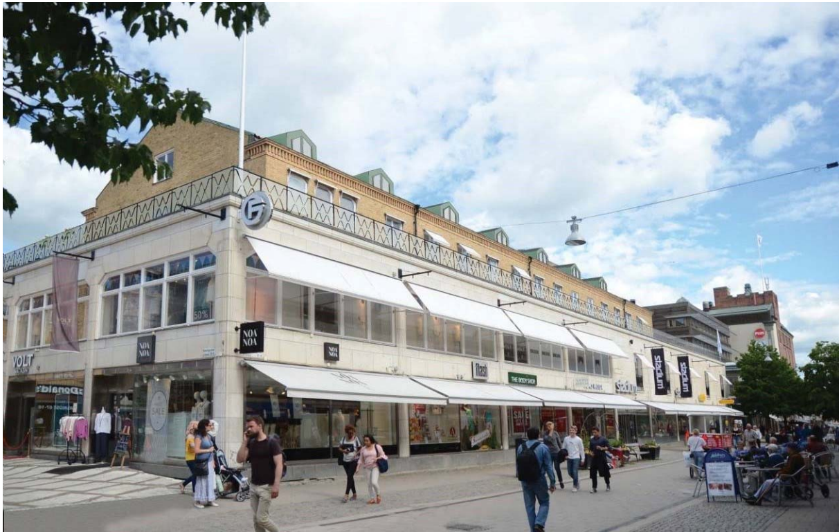
Fotomontage som visar Forumgallerian sedd från Kungsängsgatan med den föreslagna förändringen av takkupor, fönstersättning och glasräcket innanför det befintliga räcket. A-sidan Arkitekter och BAU.
