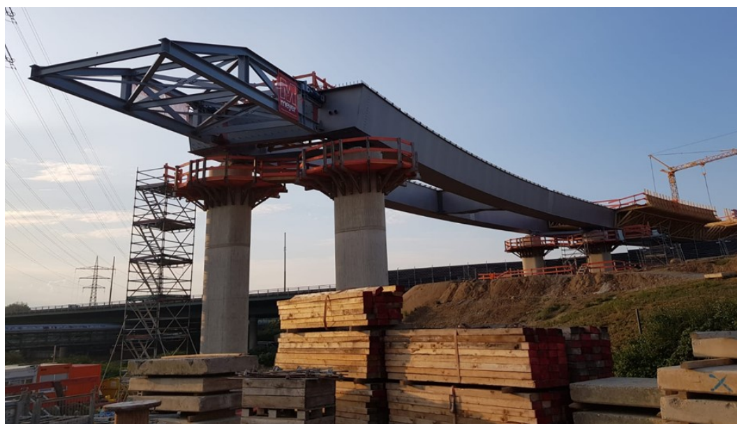
Figur 11: Lansering av broöverbyggnad med lanseringsnos.
