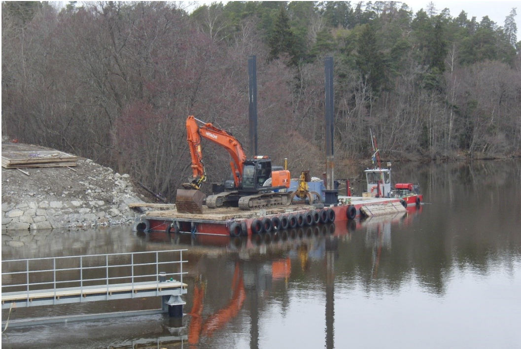
Figur 27. Arbetsplattform som två stödben och landgång till stranden.
