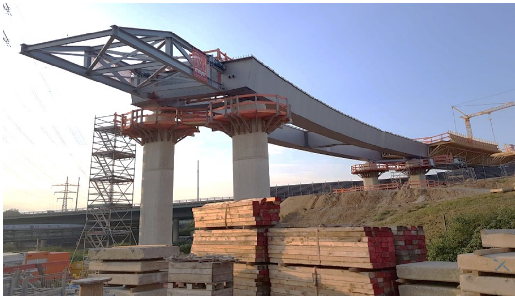
Figur 25. Lansering av broöverbyggnad med lanseringsnos.
