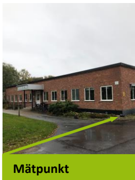
Bild 1. Vy över byggnad, mätpunkt 43.1.
