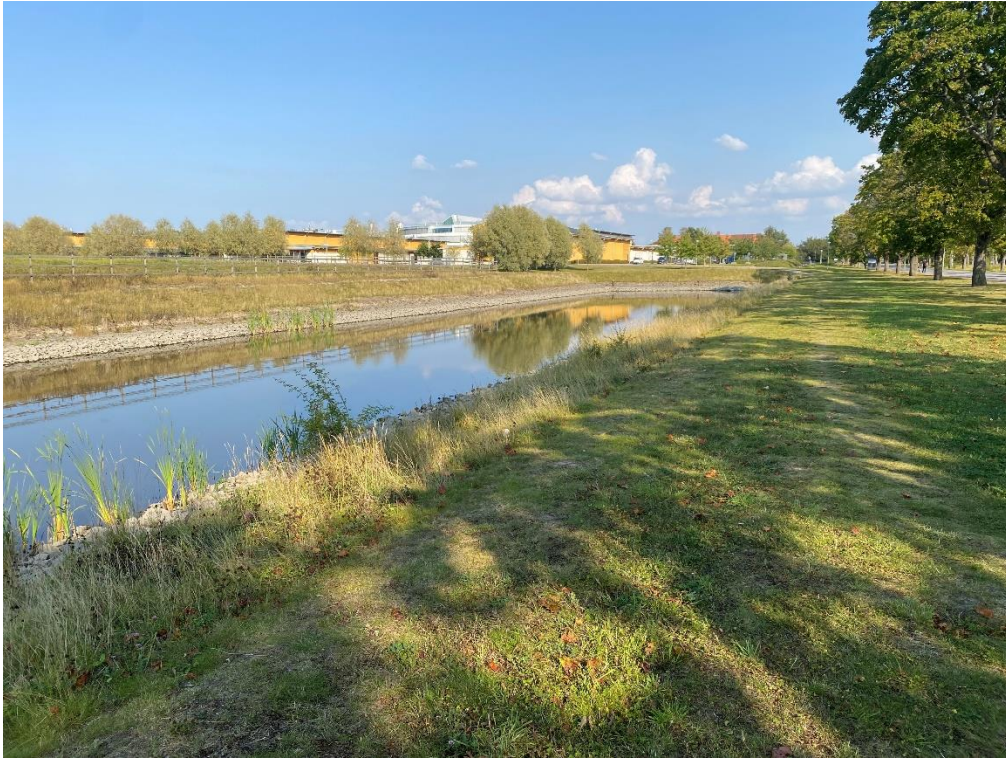
DAGVATTENDAMM PÅ ULTUNA 2:1 SOM PÅVERKAS AV DEN FRAMTIDA ANLÄGGNINGEN.
