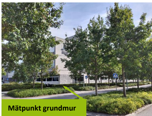
Bild 1. Vy över byggnad, mätpunkt 33.1.
