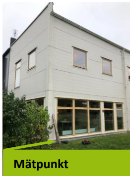
Bild 1. Vy över byggnad, mätpunkt 46.2.
