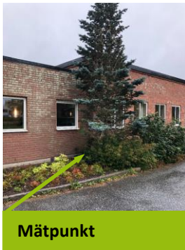
Bild 1. Vy över byggnad, mätpunkt 43.2.
