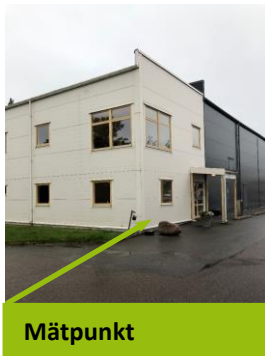
Bild 1. Vy över byggnad, mätpunkt 46.1.
