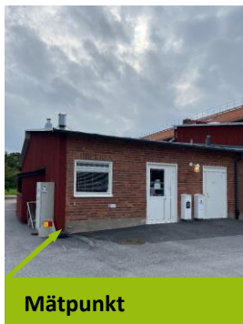
Bild 1. Vy över byggnad, mät punkt 37.1.
