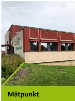
Bild 1. Vy över byggnad, mätpunkt 38.1.
