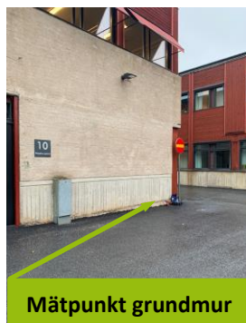
Bild 1. Vy över byggnad, mätpunkt 38.6.
