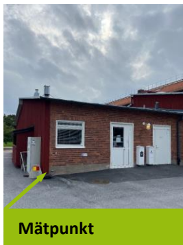
Bild 1. Vy över byggnad, mät punkt 37.1.
