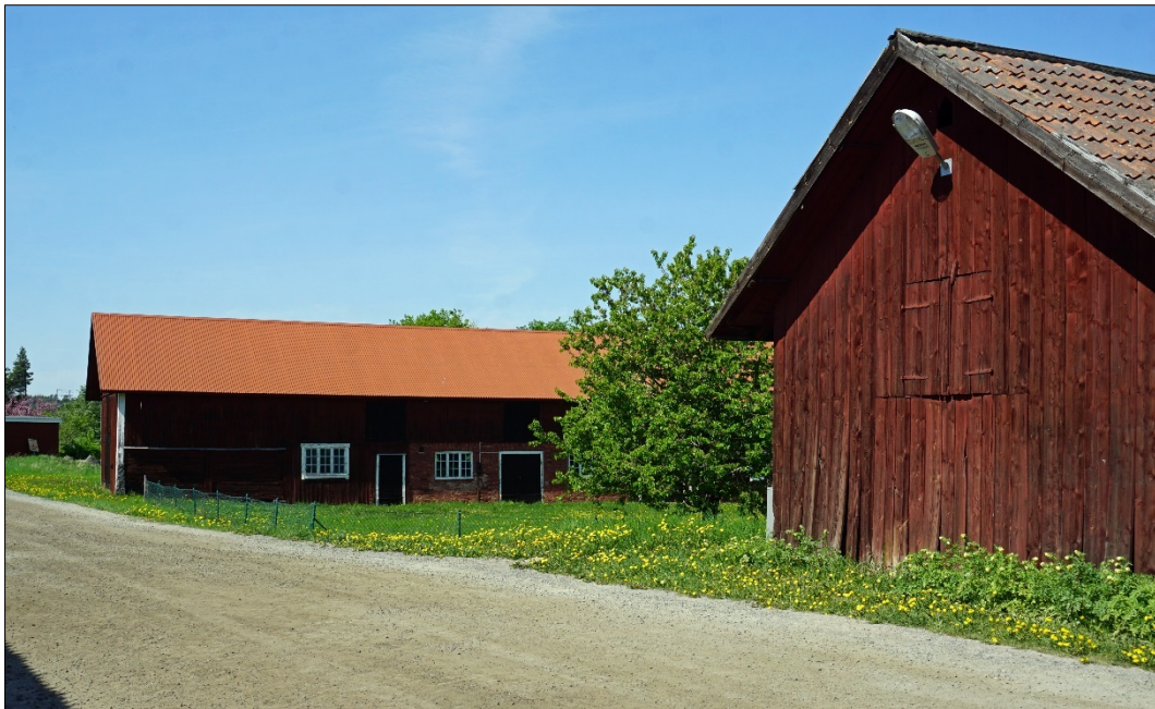
Ekonomibyggnader i Stora Söderby.
