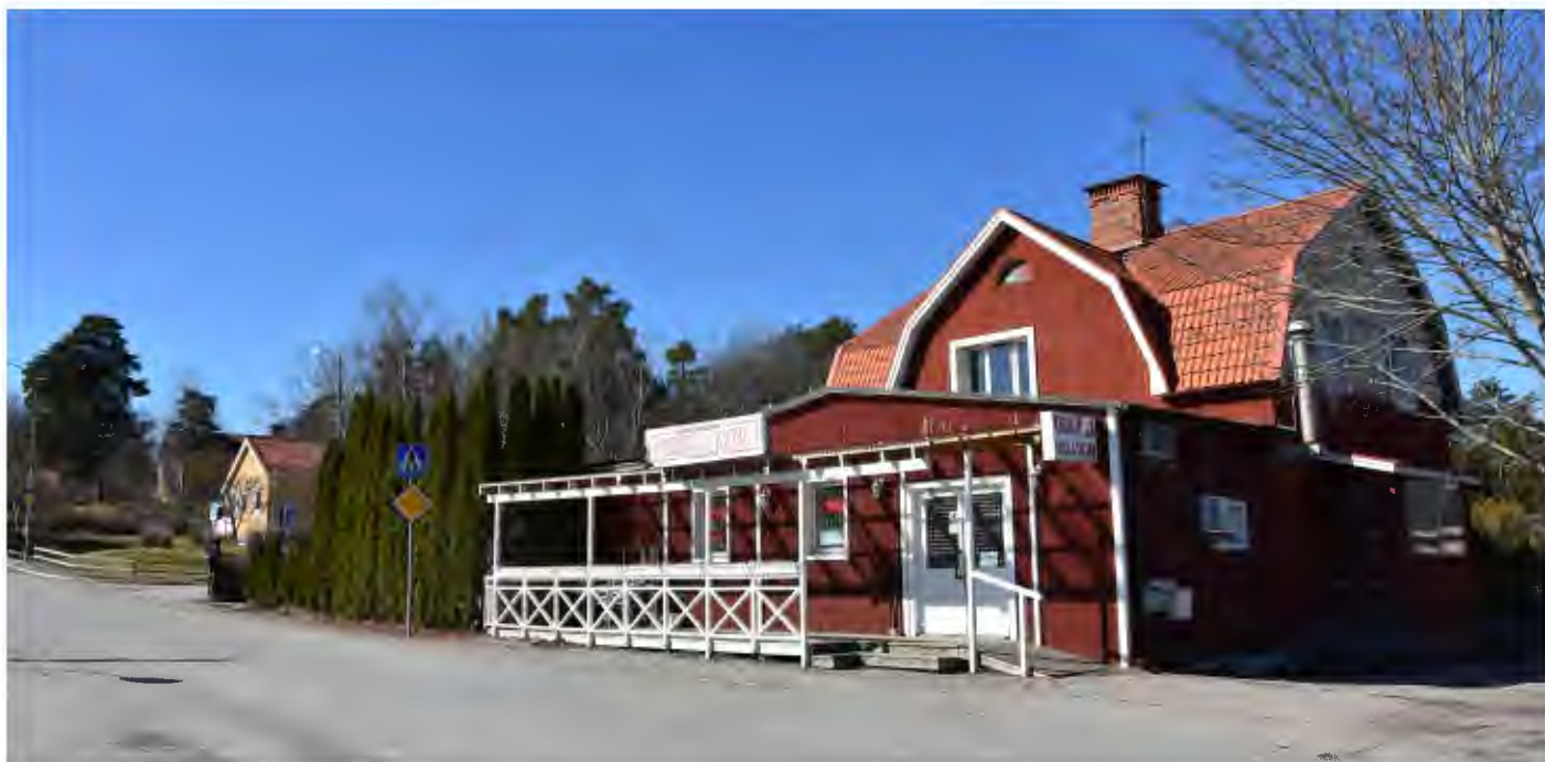
Bergsbrunna invid järnvägsövergången. Närmast i fotot en av de villor som tillkom på 1920-talet.
