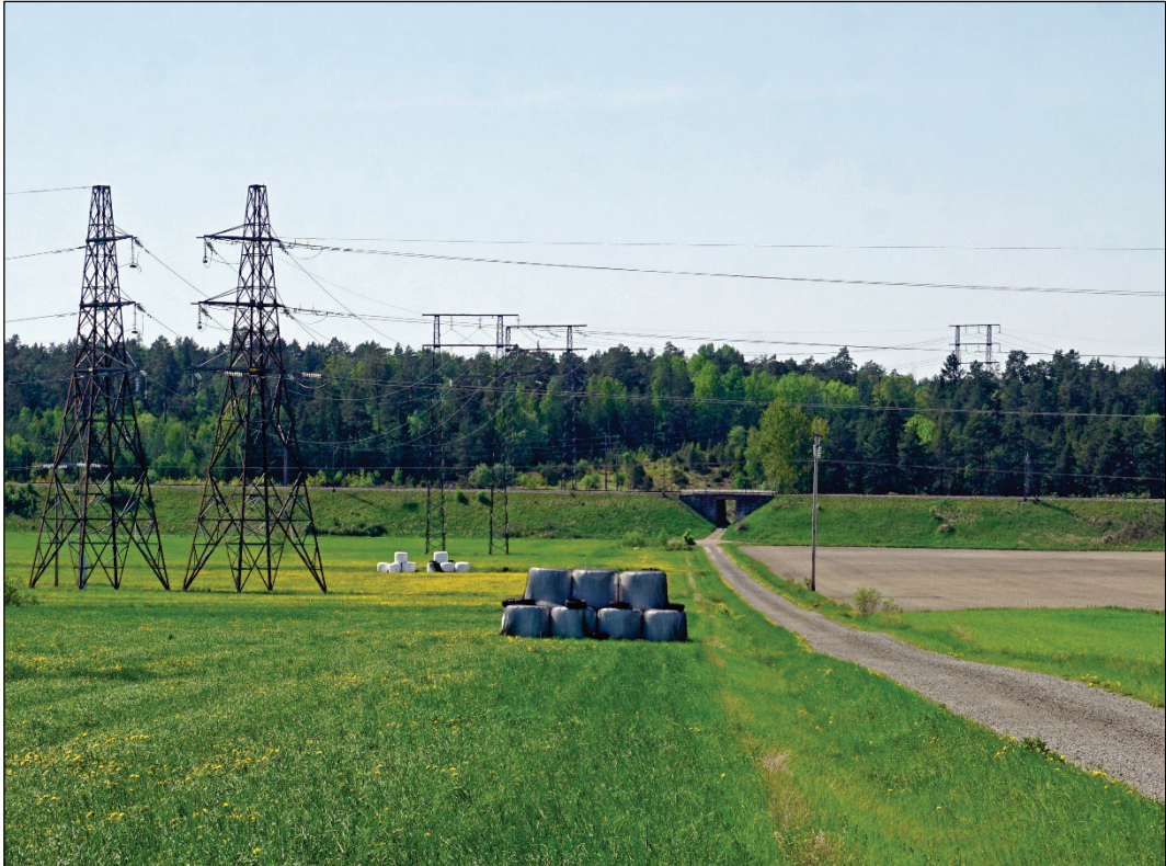
Väg med tunnel under järnvägen från Vallby till torpet Asphagen.
