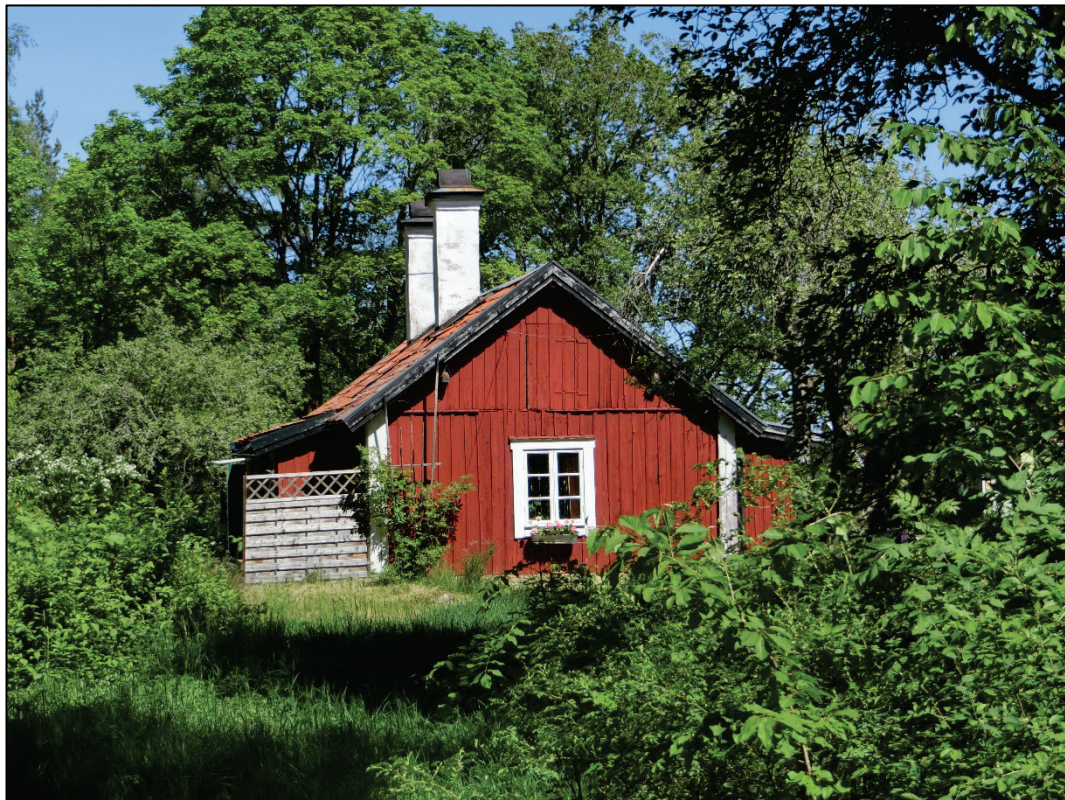
Äldre torp till Bergsbrunna gård.
