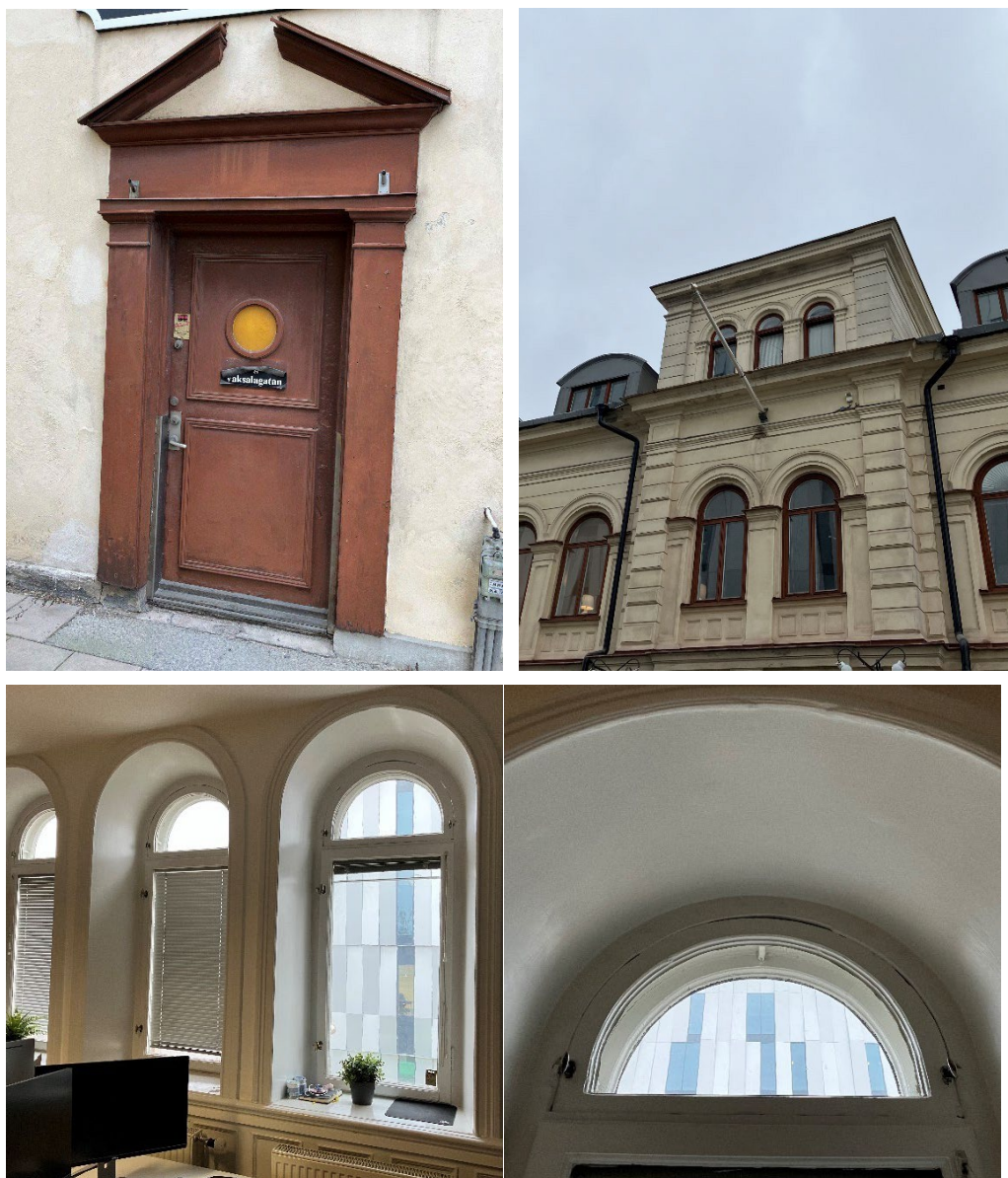
Figur 26 Dörröppning på den västra gaveln, som inte finns med på bygglovsritningar från 1935, och tre originalfönster i frontonen, sedda både in- och utifrån.
