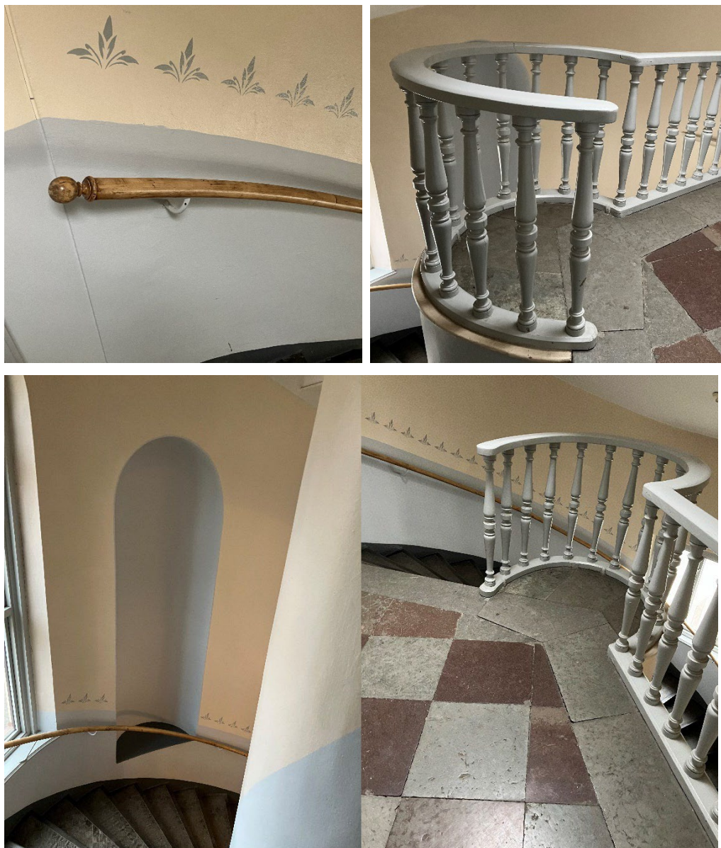
Figur 22 Trappans detaljer: räcke och nisch.
