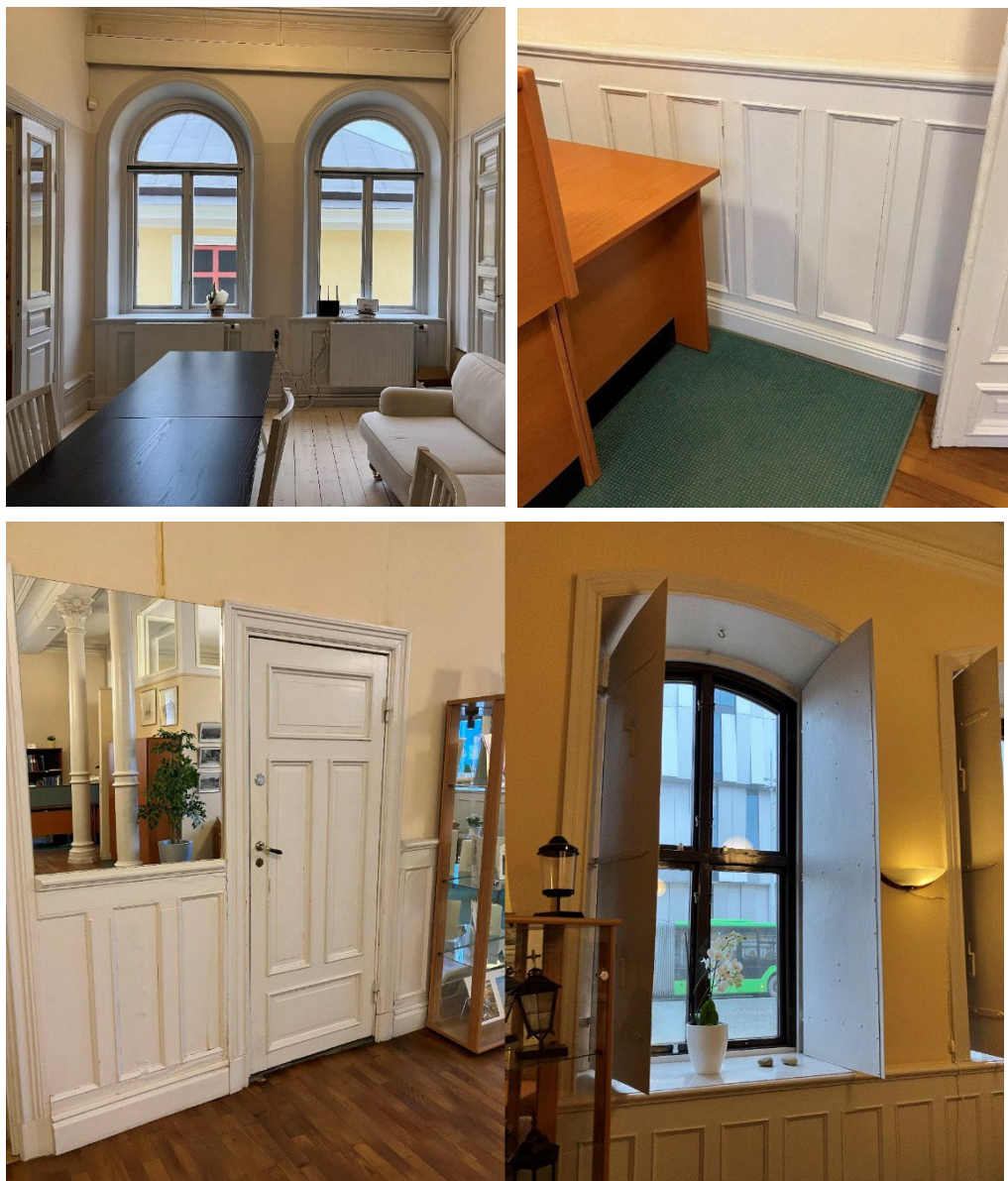
Figur 23 Taklister och andra inredningsdetaljer, som bröstpaneler på bottenvåningen.
