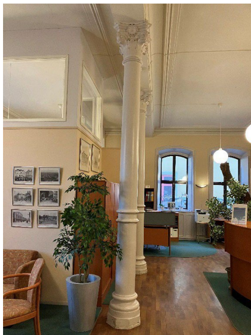
Figur 19 Ursprungliga gjutjärnskolonner.
