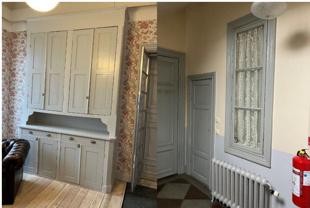
Figur 24 Serveringssskåp på sin ursprungliga plats, och invändigt fönster som troligen tillhört den tidigare vaktmästarbostaden.
