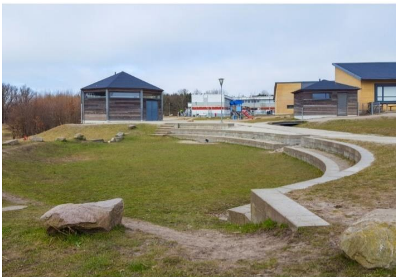
Figur 32. Exempel på multifunktionell yta där dagvatten vid skyfall tillfälligt fördröjs. Under större delen av året används platsen som lektyta. Källa: Haninge kommun
