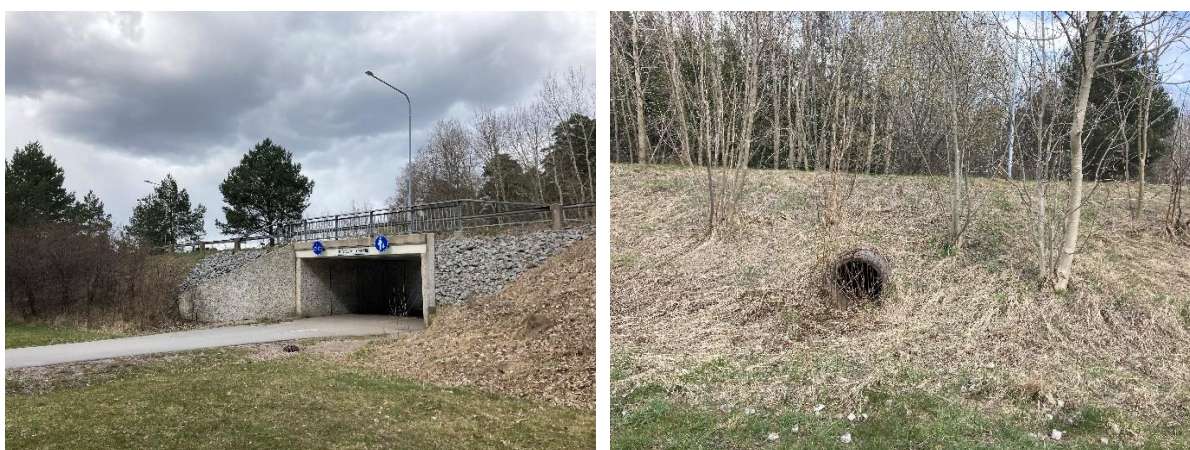
Figur 14. Till vänster: Kupolbrunnar i anslutning till GC-porten under Elfrida Andréés väg. Till höger: Trumma under Elfrida Andréés väg. Foto: WSP (2021).
