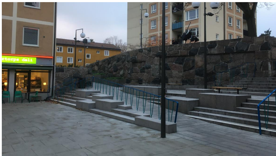
Figur 37 Påkostad ny trappa i Kärrtorp Centrum.
