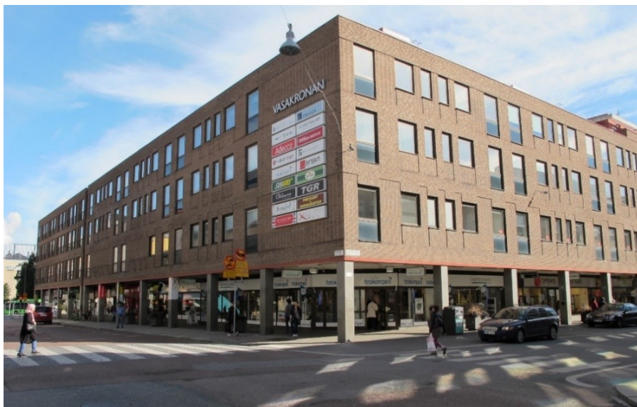
Mot Vaksalagatan och Dragarbrunnsgatan finns rymliga arkader i bottenvåningen.
