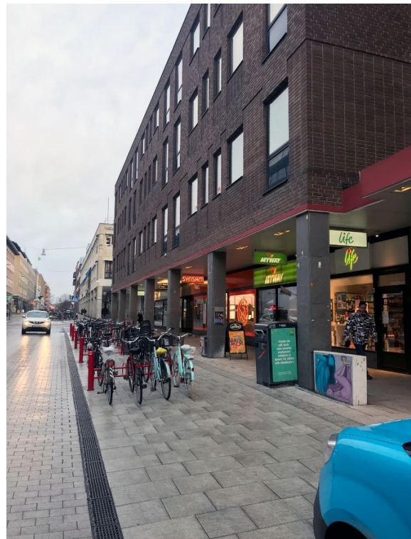
Dragarbrunnsgatan efter ombyggnaden till gångfartsområde 2019. Gaturummet är möblerat med cykelställ som avskiljer gångytorna närmast fasaden från biltrafik.
