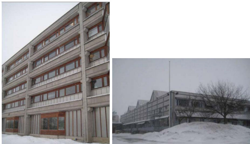
9 Till vänster, hus 35, huvudkontoret. Synlig bärande stomme av prefab betongelement, fasader av rostfri plåt, fönster av teak.
