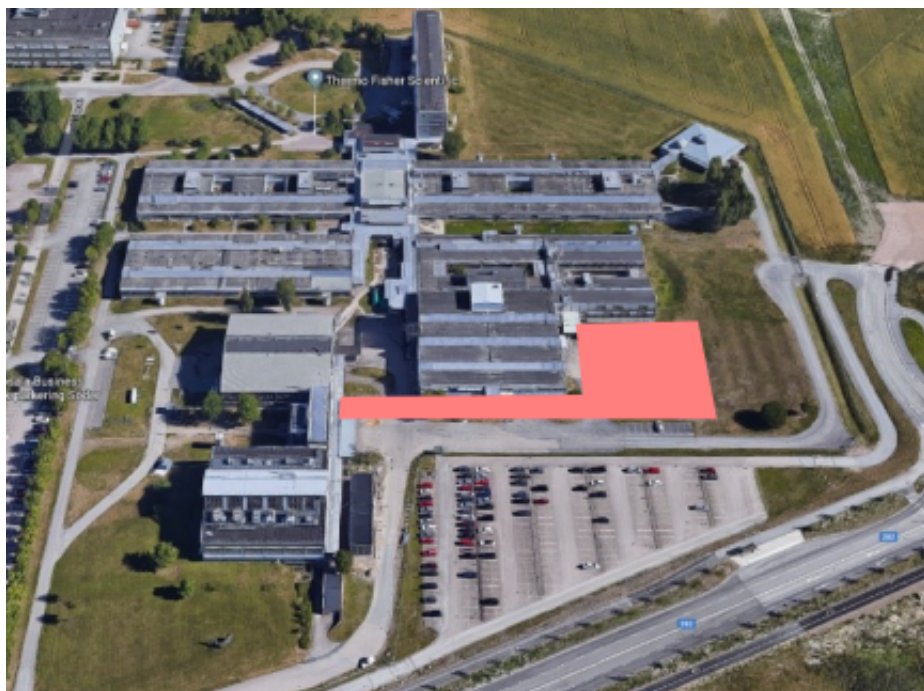
6 Flygfoto över fastigheten Fyrislund 6:11. Område för nytt höglager och förbindelsegång är markerat i rött.
