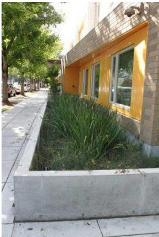
Figur 16. Exempel på upphöjd växtbädd som tar hand om vatten från stuprör. (Foto: WRS)
