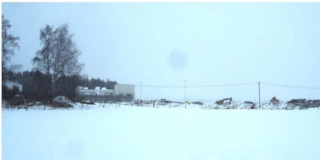
Figur 16 Pågående arbete med att anlägga en bussdepå, strax öster om Söderhällby
