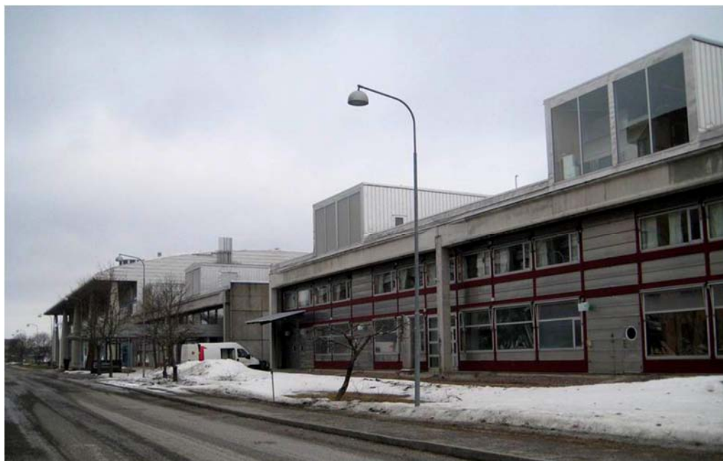
Figur 29 AMO:s fasad mot Virdings allé, hus 7.
