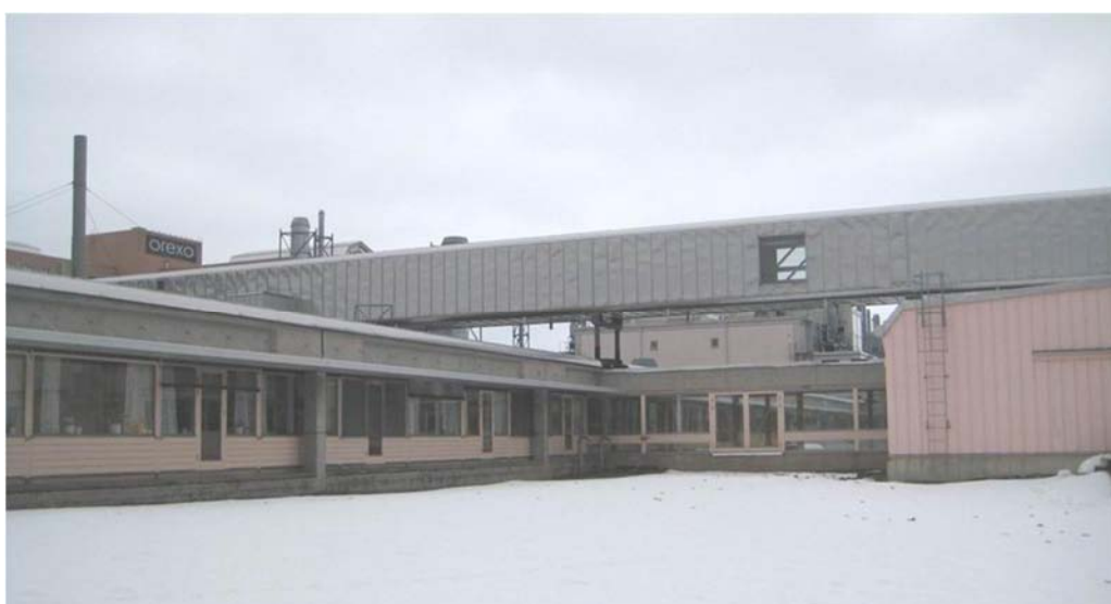
Figur 26 Över västra förbindelselänken har ett nytt stråk för tekniska installationer byggts.
