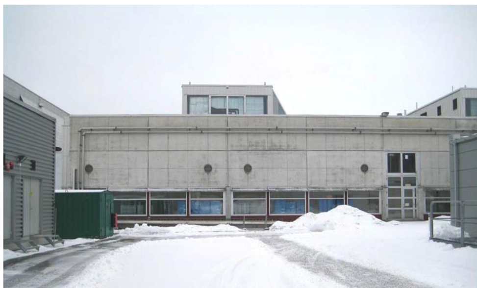
Figur 30 AMO, hus 21 norra fasaden.
