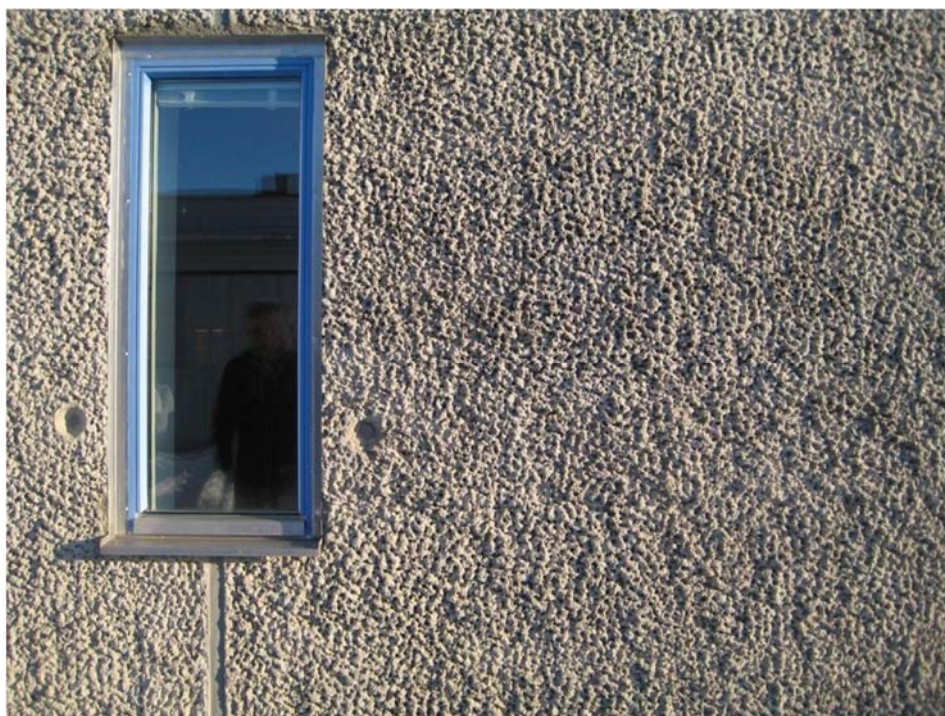
Figur 32 Fresenius-Kabis stora lagerbyggnader 10a och b har väggar klädda med stora prefabricerade betongskivor.
