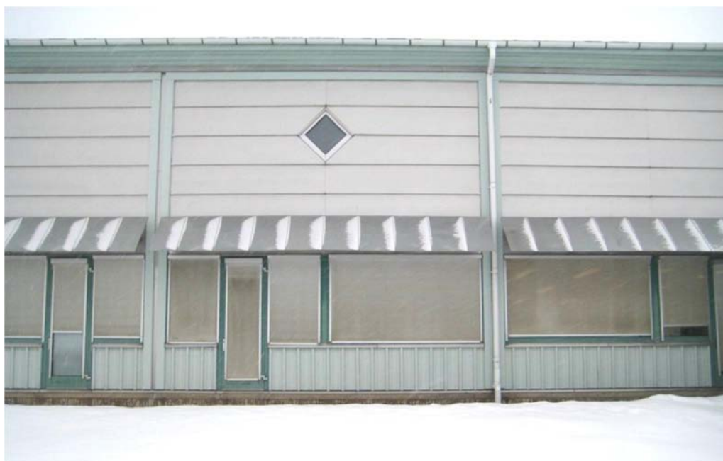
Figur 34 GE, hus 61, fasad mot söder som är klädda med rostfri plåt i ett ramverk av trä och panelklädda fönsterbröstningar.
