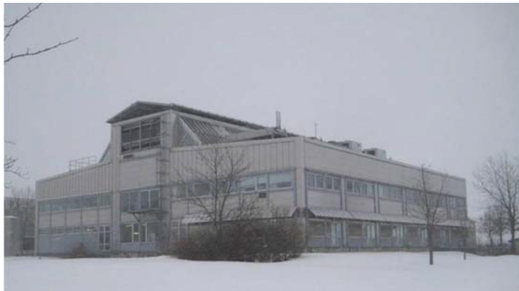
Gaveln på hus 40. Fasader av rostfri plåt. Panel och ramverk av trä. Sadeltak över mittskeppet har tillkommit senare för att skydda installationer. Bild: Kulturmiljöutredning, WSP
