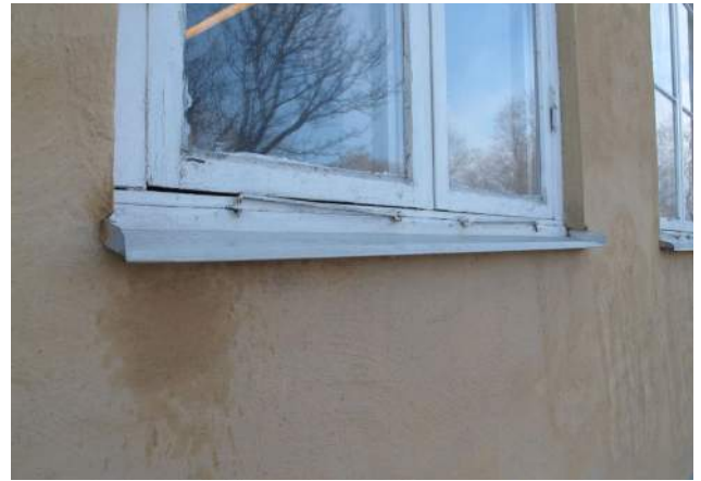
Fönstersnickerier från 1930-talet är delvis bevarade på huset.
