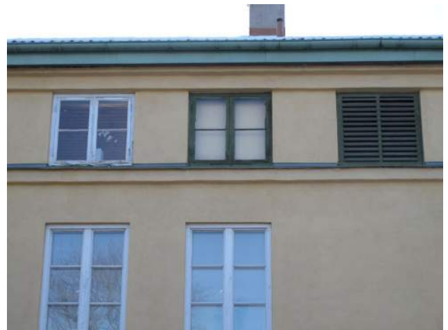
Vindsvåningens fönstersnickerier är bevarade i ursprungligt skick.
