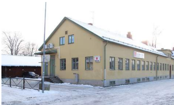
Fasad mot Alsikegatan.
