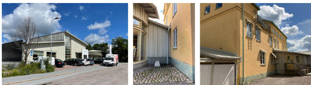
Bild 21 Foton på Boländerna 7:4. Delen mot Östunagatan som är sammanbyggd med Bryggeriet kom till på 1990-talet. Till vänster fasaden mot Östunagatan, till höger länken mellan nya och gamla byggnaden som syns från Säbygatan samt tilläggen sett från gårdssidan.
